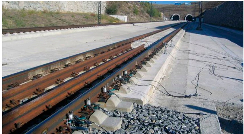
Instrumentación para el estudio del comportamiento de la transición vía en placa- vía sobre balasto
