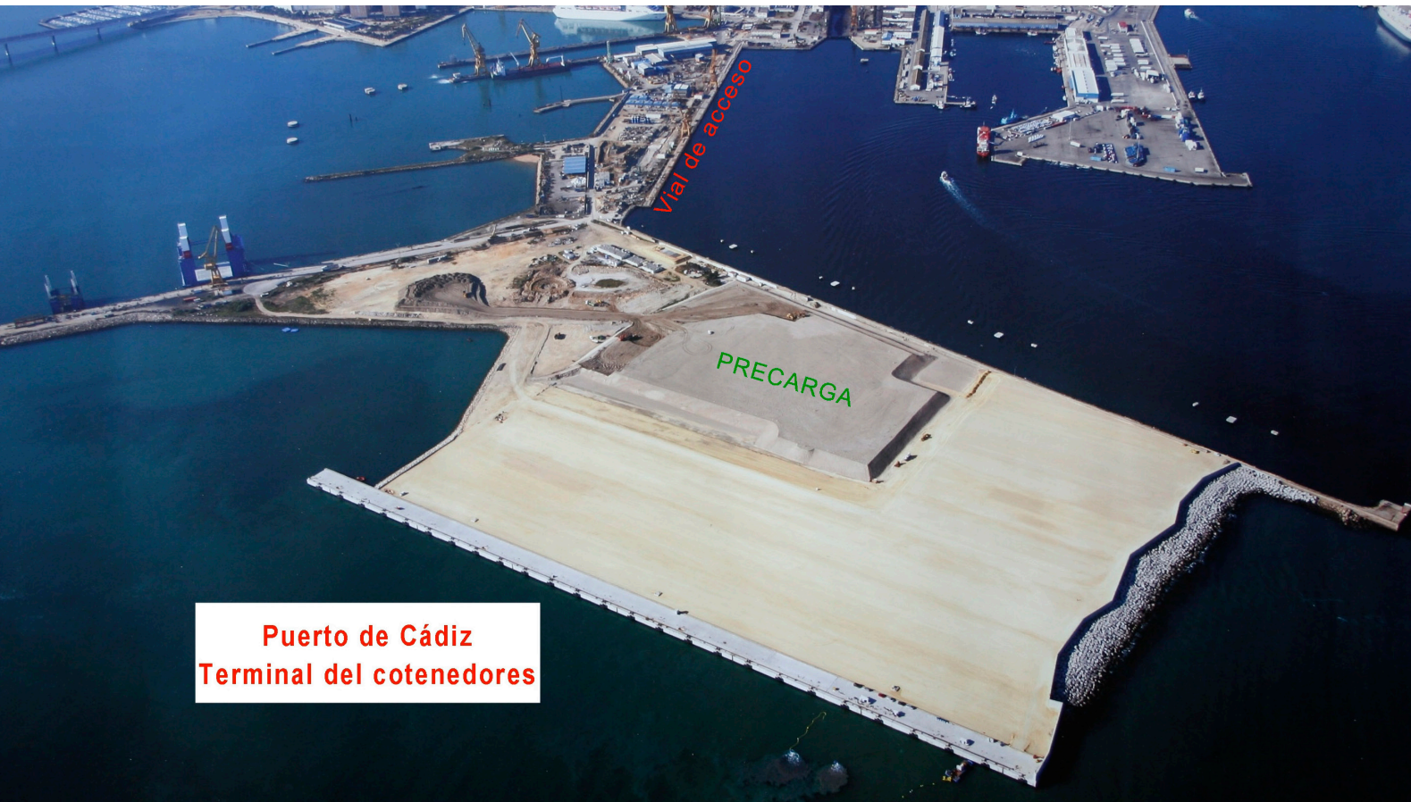
Asesoramiento geotécnico al Puerto de Cádiz durante la construcción de la nueva terminal de contenedores. Tratamiento de precarga.
