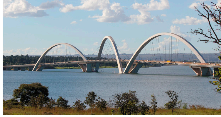
Puente Jusceliano Kubistchek donde se aprecian los arcos entrelazados.
