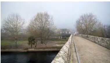
REHABILITACIÓN DE PUENTE MEDIEVAL - ALO0253 Ponteledesma. Boqueixón abalo alonso arquitectos
