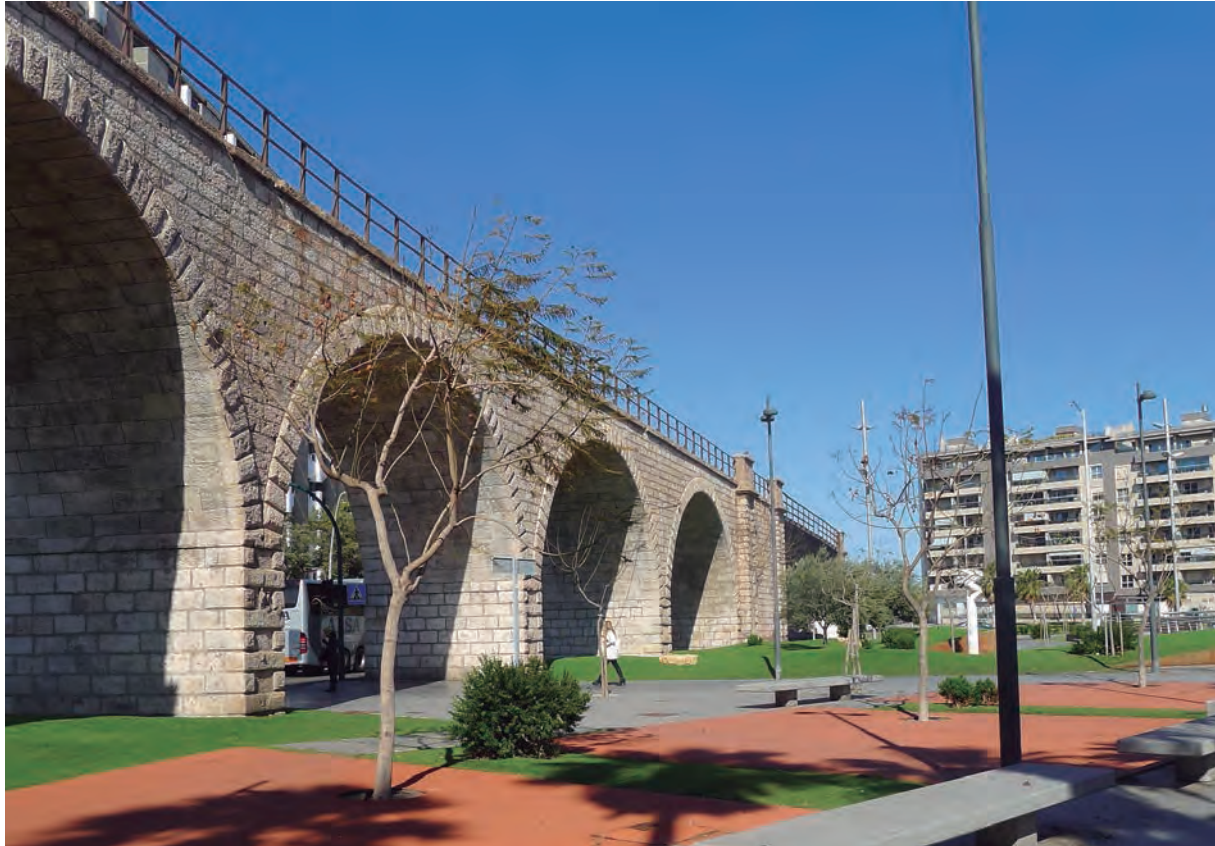
► Viaducto de sillería en el tramo de acceso desde la estación.
