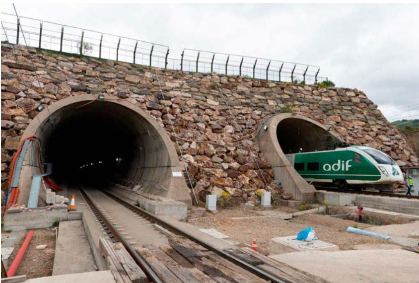
Boca de los túneles de Pajares y tren de Adif AV en pruebas asomando por uno de los tubos.
