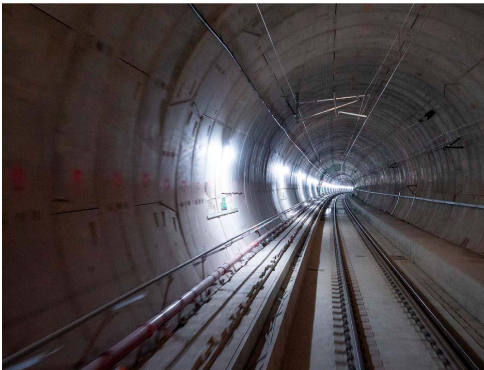
Interior de uno de los túneles de base de la variante.
