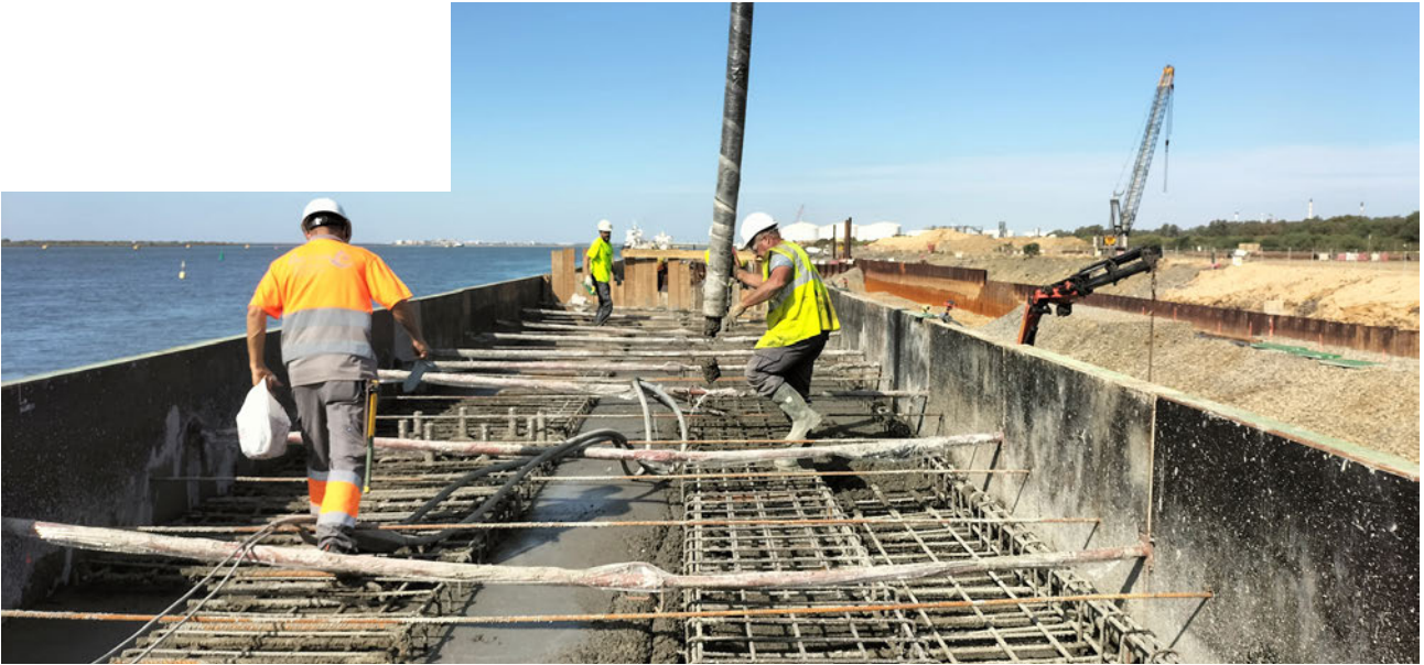
Hormigonado viga cantil.
