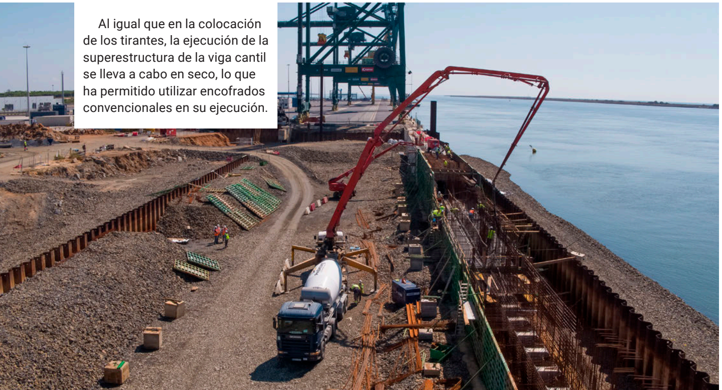
Construcción en seco de la viga cantil.
