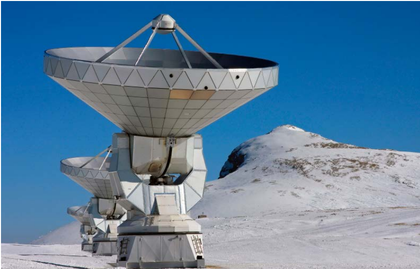
La parábola de cada antena está protegida (forrada) con una estructura que ayuda a mantener su temperatura constante. Al fondo el Pico de Bure | IRAM.
