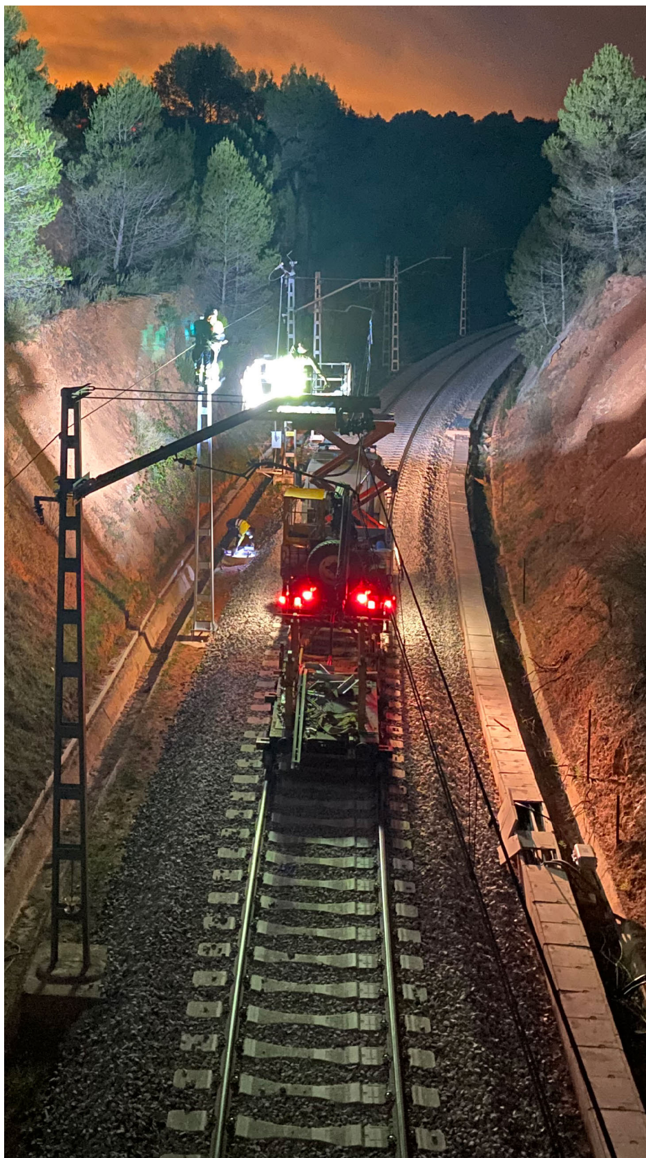
Trabajos nocturnos en el tramo Castellbisbal-Martorell.
