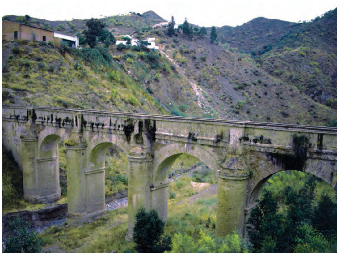
► Acueducto de San Telmo. Málaga. Obra de ingeniería hidráulica del s. XVII.
