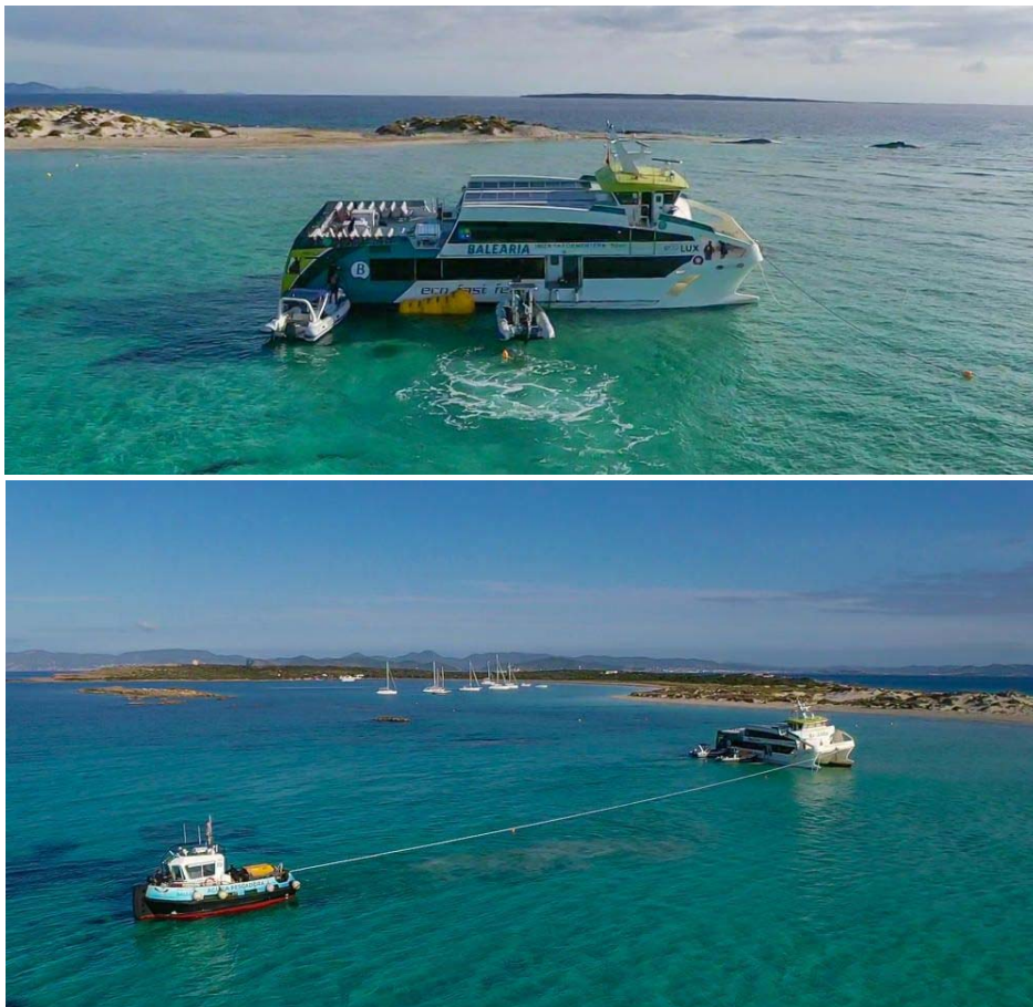
Figura 6. Trabajos de reflotamiento de la nave
