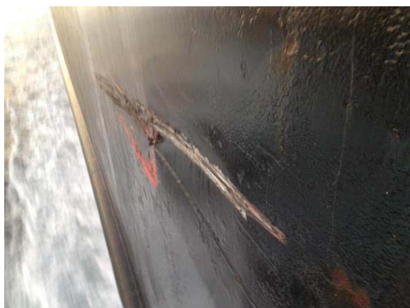
Figura 5. daños en el ro-ro BOUZAS
