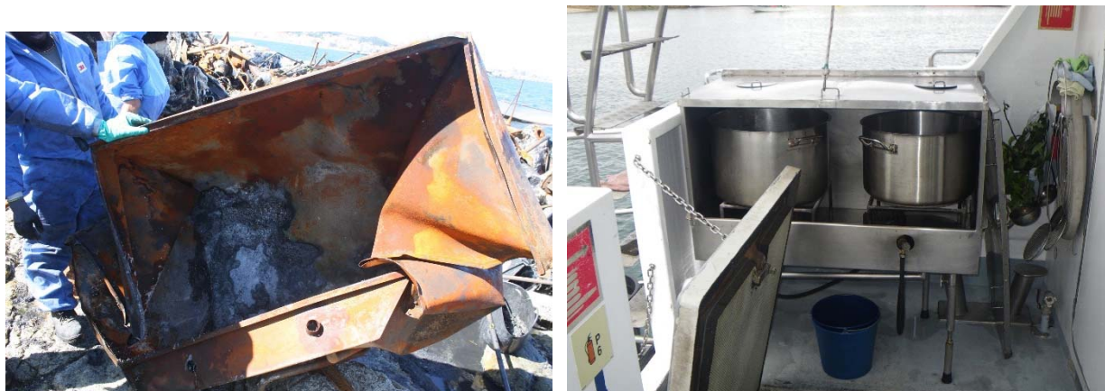
Figura 9. Cocina del BORAMAR, foto tomada el 10/08/2018 (izquierda), y cocina del VISION DOUS, del mismo armador (derecha)
