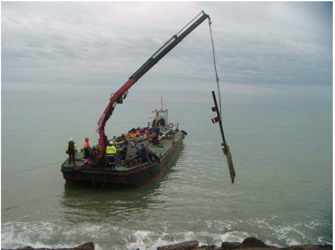
Figura 5. Remoción de los restos de la E/P GERMANS PERIS frente al dique
