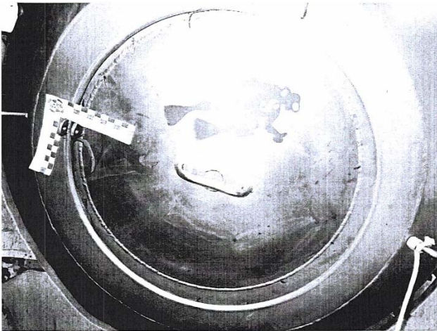
Figura 5. Entrada de la cámara
