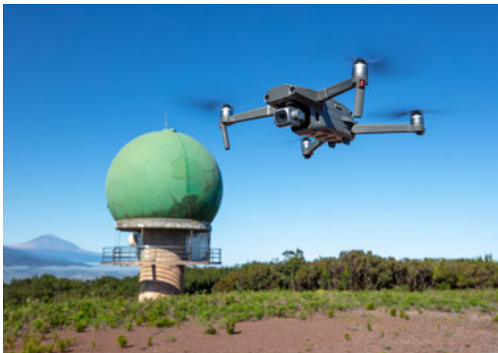
Dron volando cerca de instalaciones de navegación aérea de ENAIRE en las inmediaciones del Aeropuerto de Tenerife Norte.
