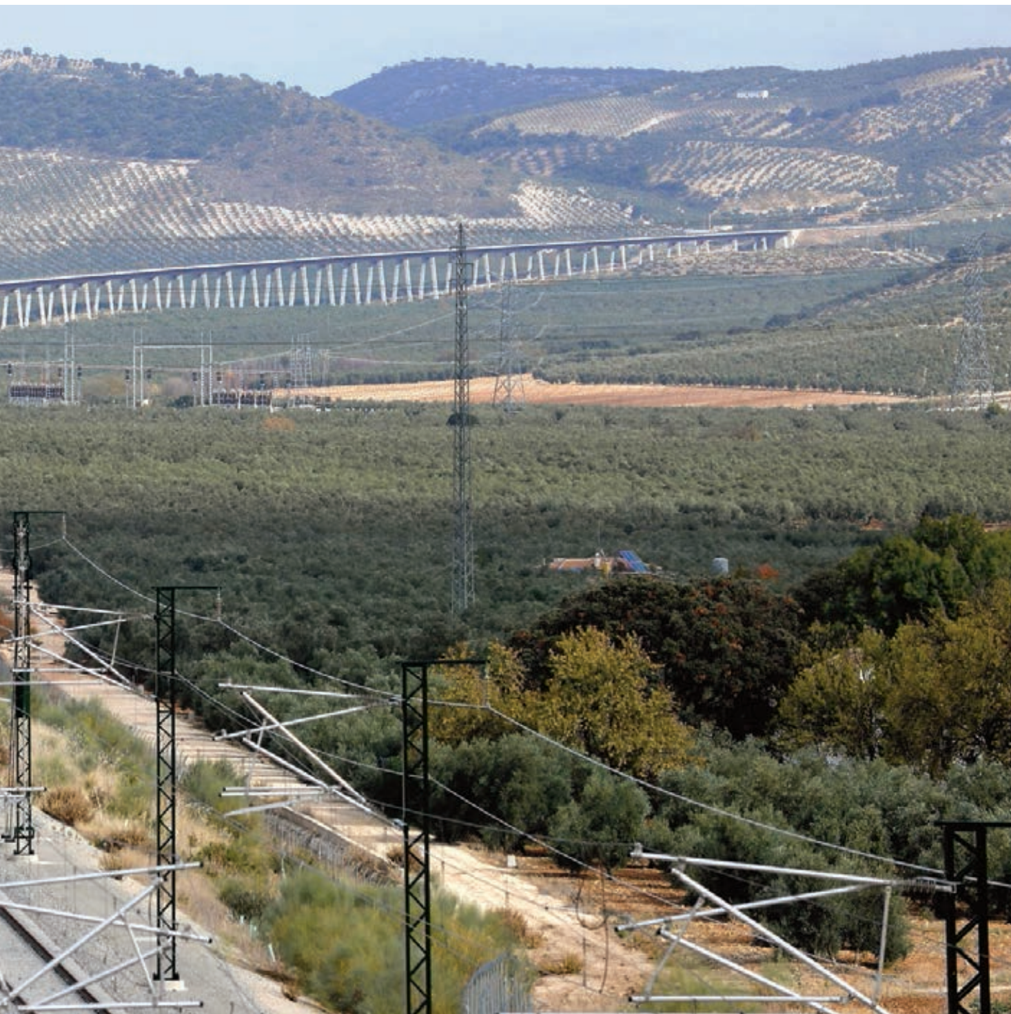
► Viaducto de Archidona (3,1 kilómetros), construido para evitar la afección a unos acuíferos.
