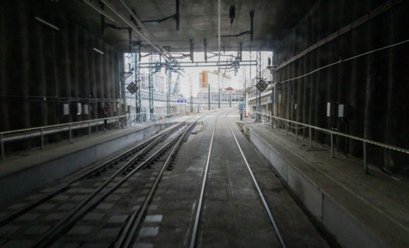
Interior del túnel con la estación de Chamartín-Clara Campoamor al fondo.
