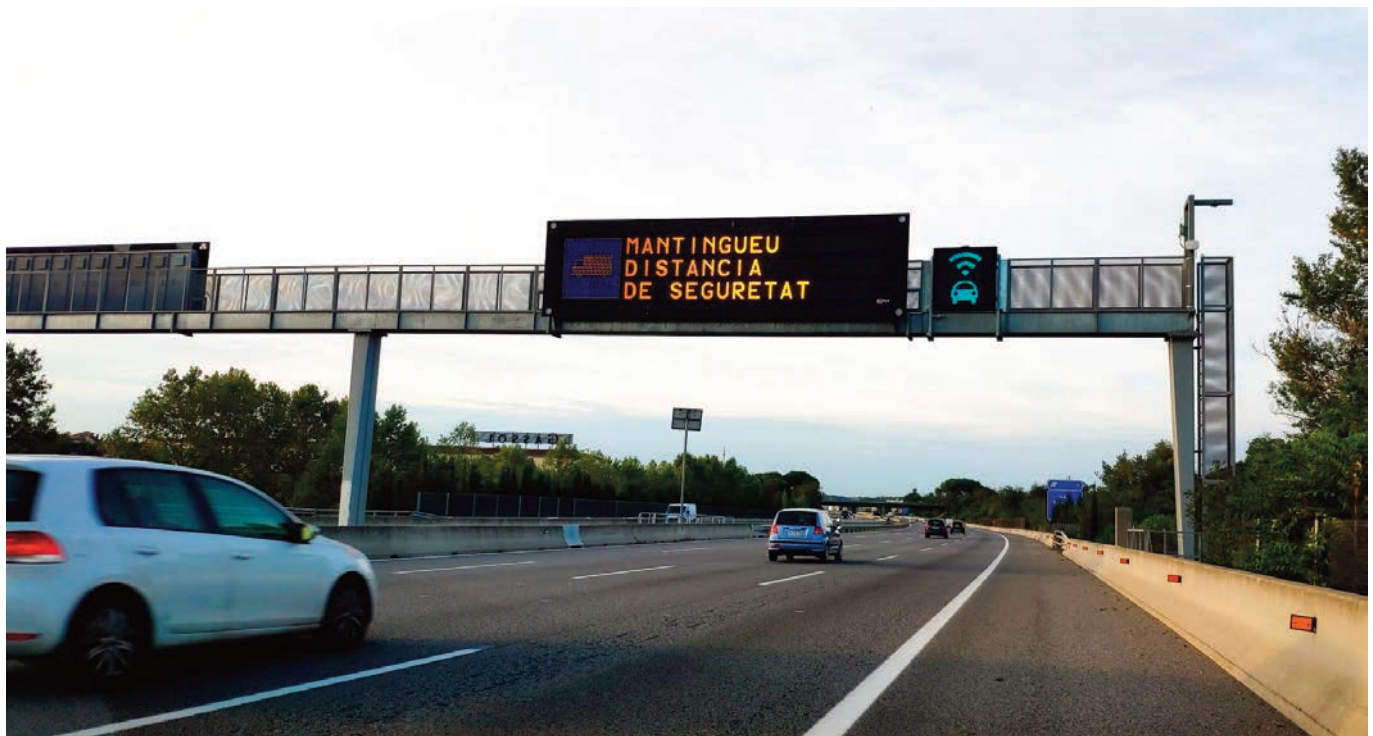
► Panel de señalización variable del tramo de la AP-7 donde se realizarán las pruebas. Derecha, pictograma de vehículo autónomo y conectado dibujado sobre el firme de la AP-7.
