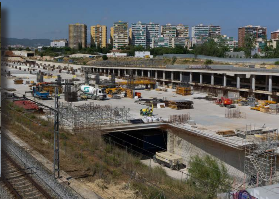
El primer forjado de hormigón cubre toda la superficie de la futura terminal.
