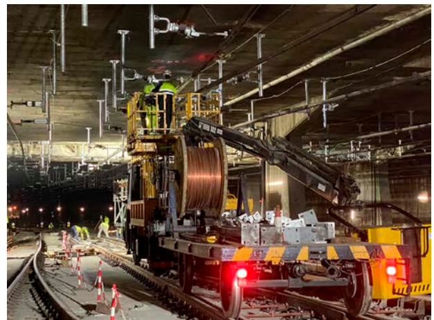
Trabajos de acondicionamiento de catenaria.
