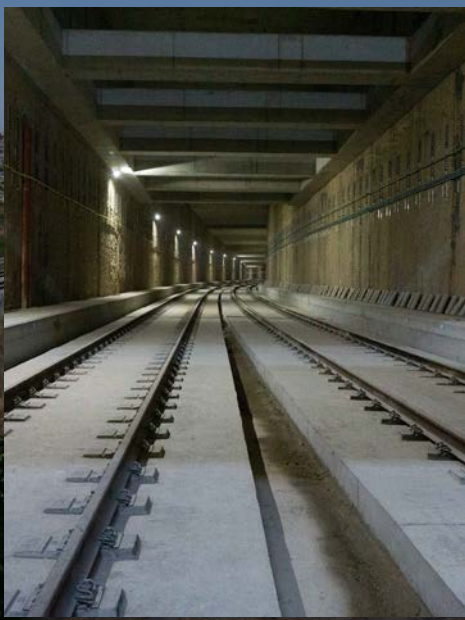
Acceso soterrado a la estación, con doble vía en placa.
