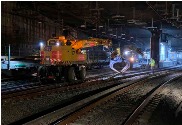
Retirada de raíles junto a los andenes.
