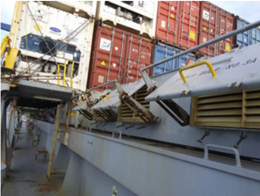
Buque portacontenedores. Ventilación natural de bodega en de carga.
