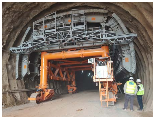
Carro de encofrado de la bóveda del revestimiento.
