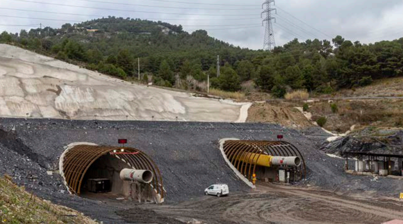
Emboquille Sur del túnel de Lilla. Lado Vallès.
