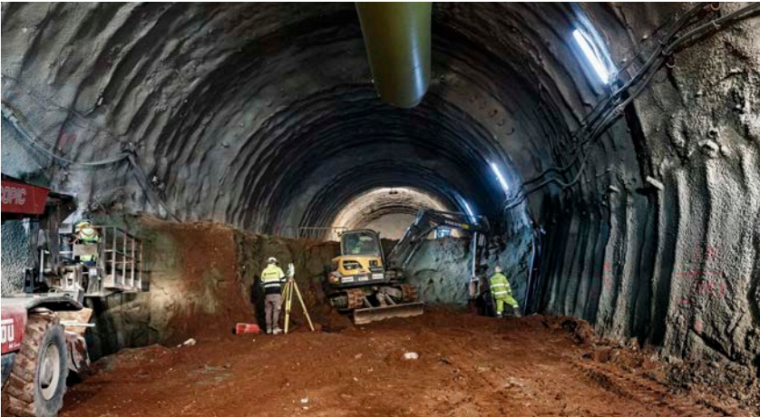
Excavación del túnel en avance y destroza.
