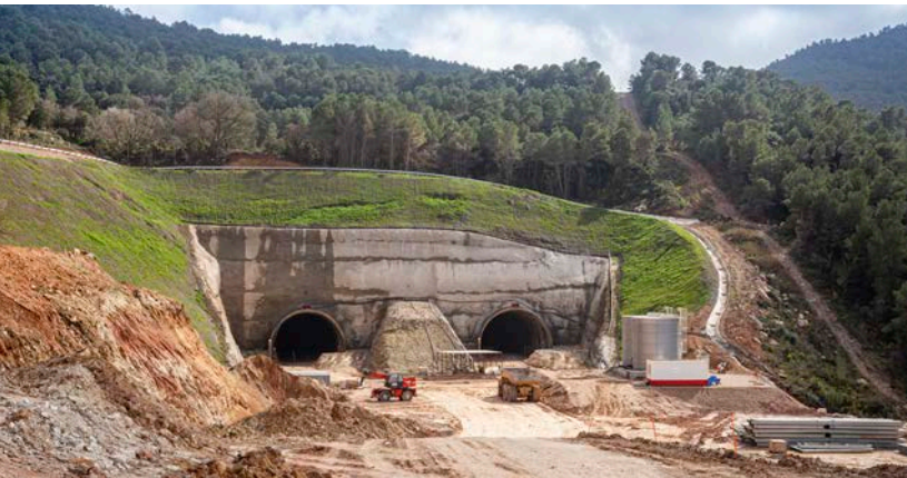
Emboquille Norte del túnel de Lilla. Lado Montblanc.
