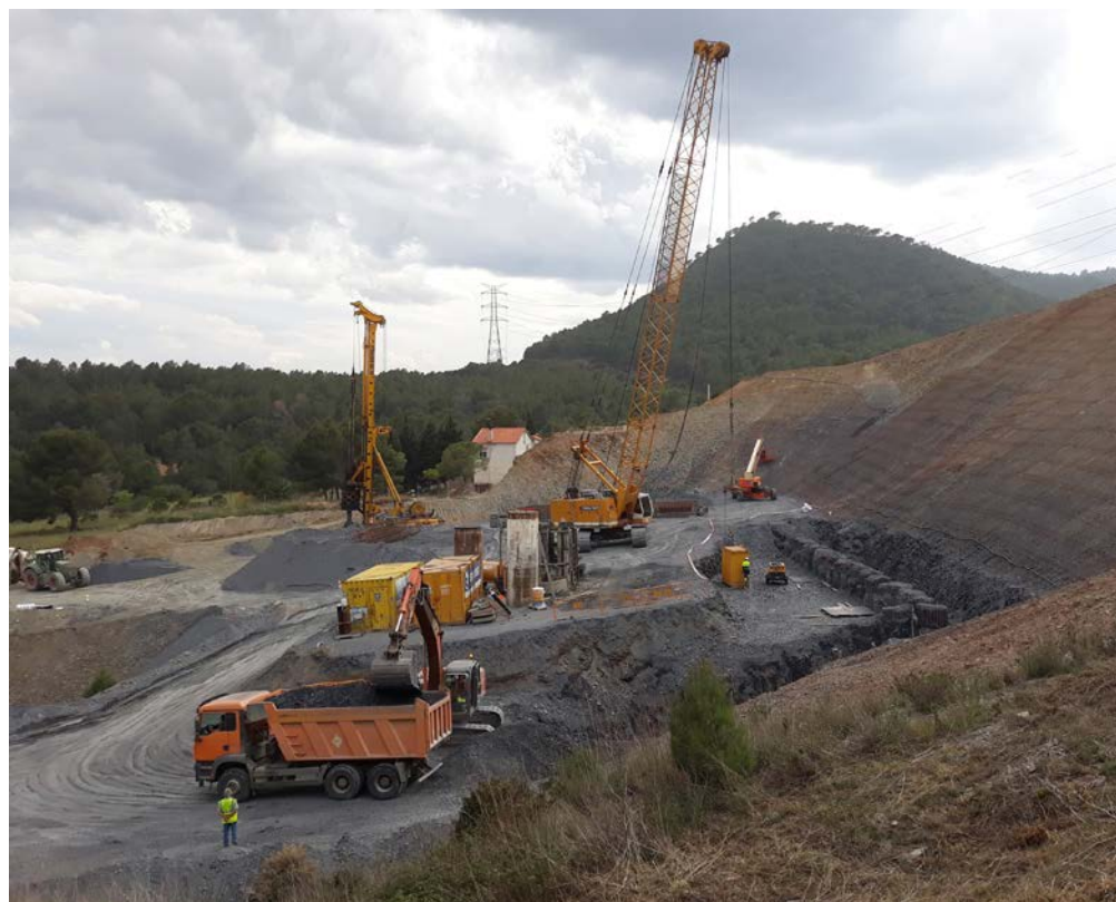
Ejecución de pantalla de pilotes en emboquille Sur (lado Valls).
