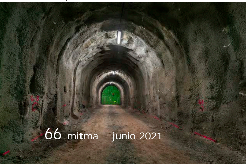
Galería peatonal de conexión entre tubos.
