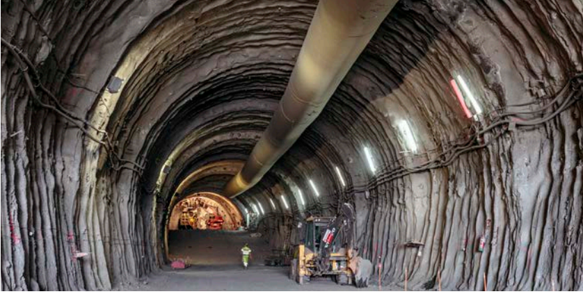
Excavación del túnel en avance y destroza.
