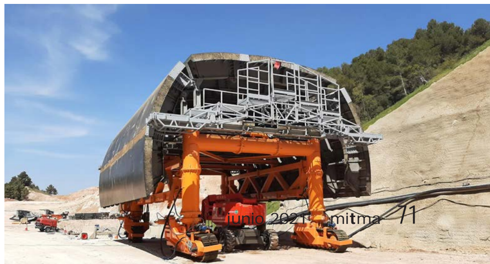
Carro de encofrado de la bóveda del revestimiento.
