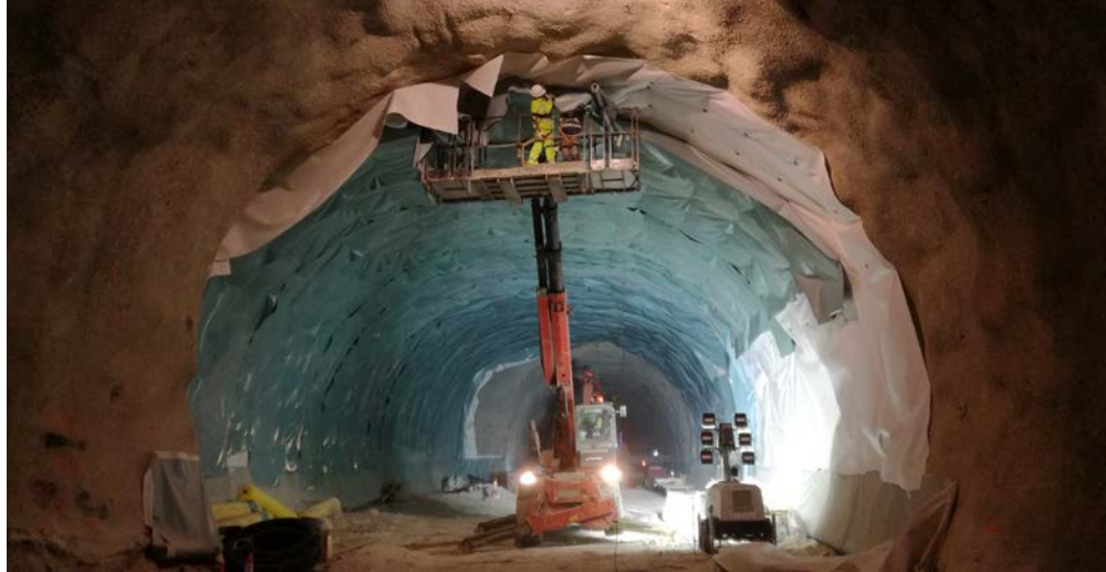
Colocación de las láminas de impermeabilización en la bóveda.
