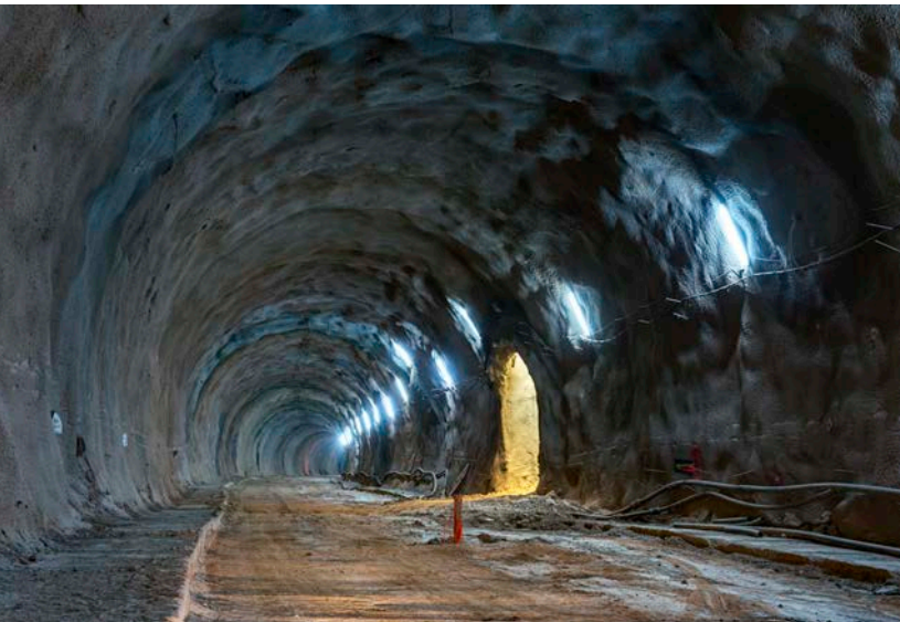
Tubo Oeste calado a sección completa.
