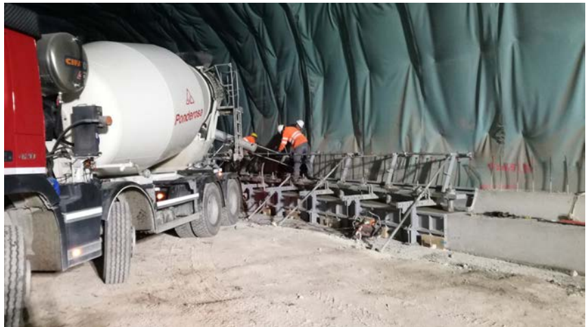
Hormigonado de las aceras.
