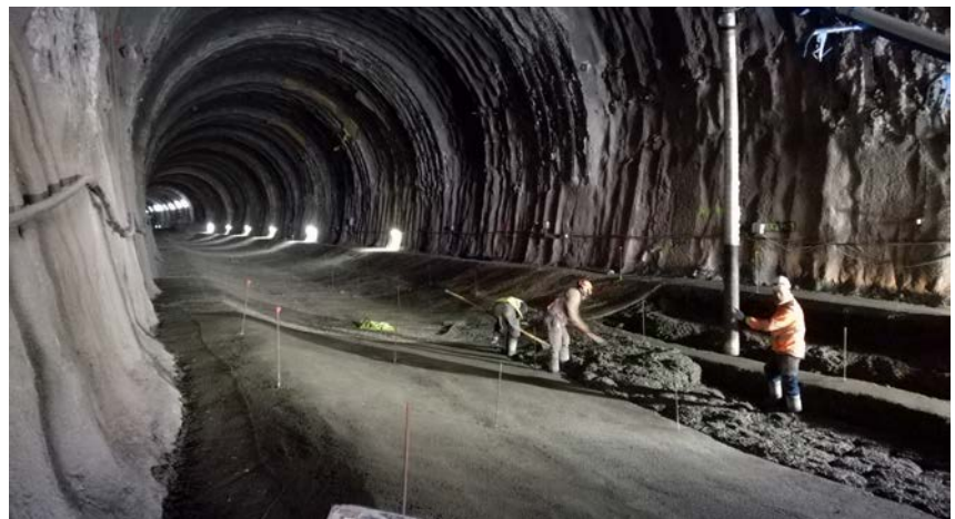
Hormigonado de la contrabóveda de revestimiento en el tramo de pizarras.
