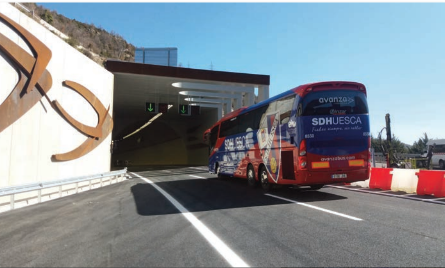
► Primeros vehículos accediendo al nuevo túnel de Caldearenas.
