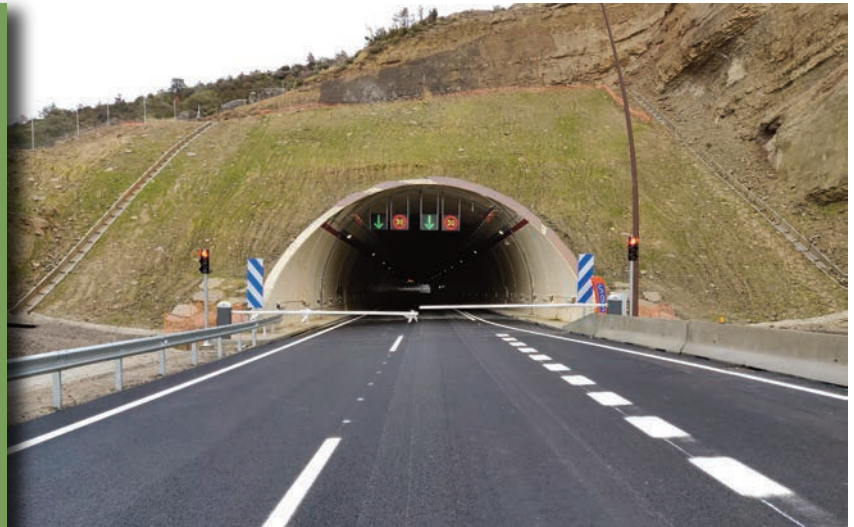
► Boca del túnel de Escusaguas.
