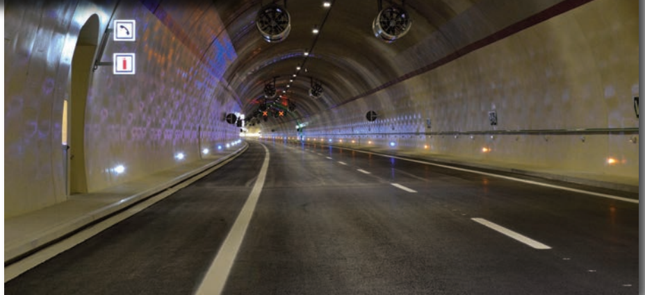
► El túnel de Caldearenas (2.997 metros) es el segundo más largo de Aragón tras el de Somport.
