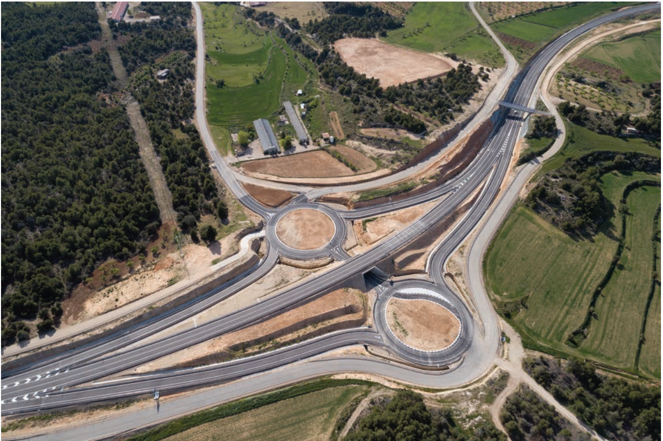
► Enlace de Torre de Arcas, con tipología de diamante con pesas.
