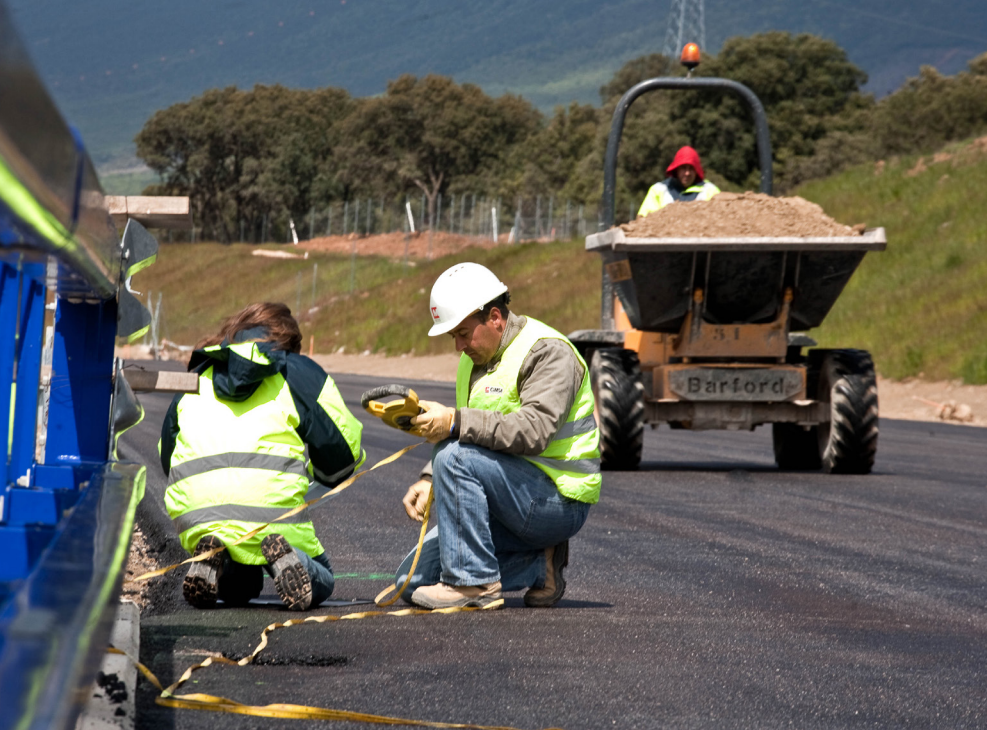
Trabajos de topografía en la A-21. Tramo: Barranco de las Colladas- Enlace A-1601.
