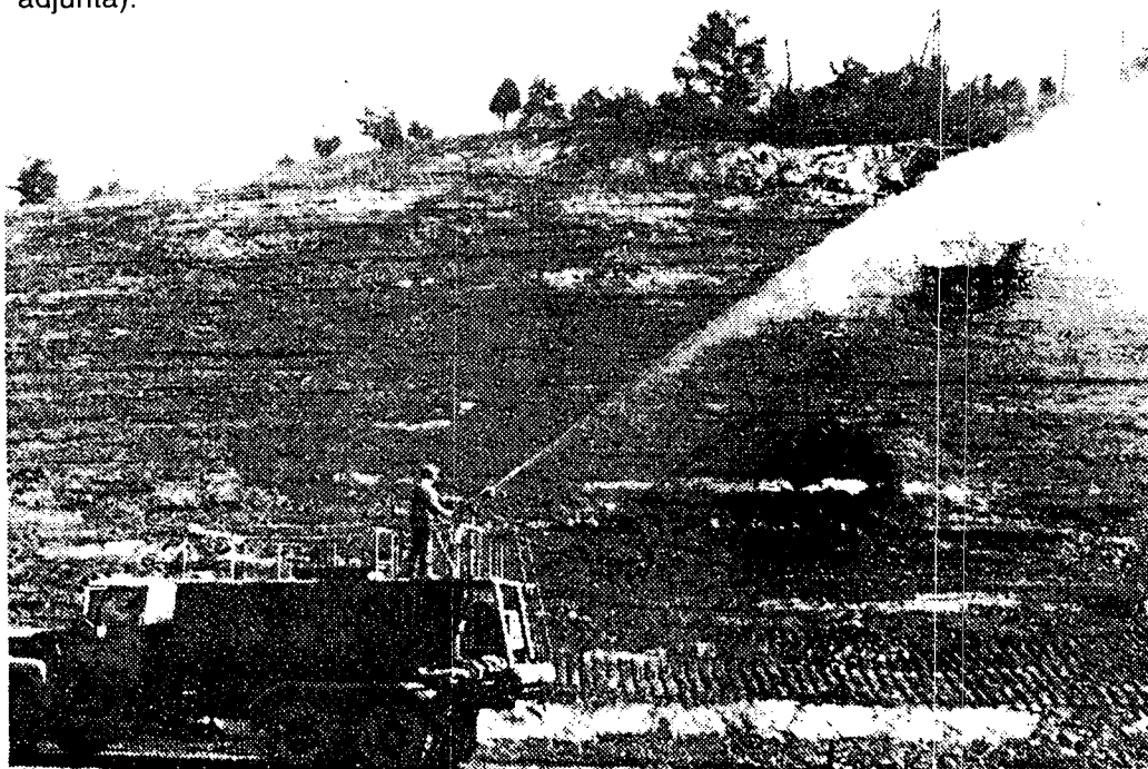
Máquina hidrosebradora trabajando
