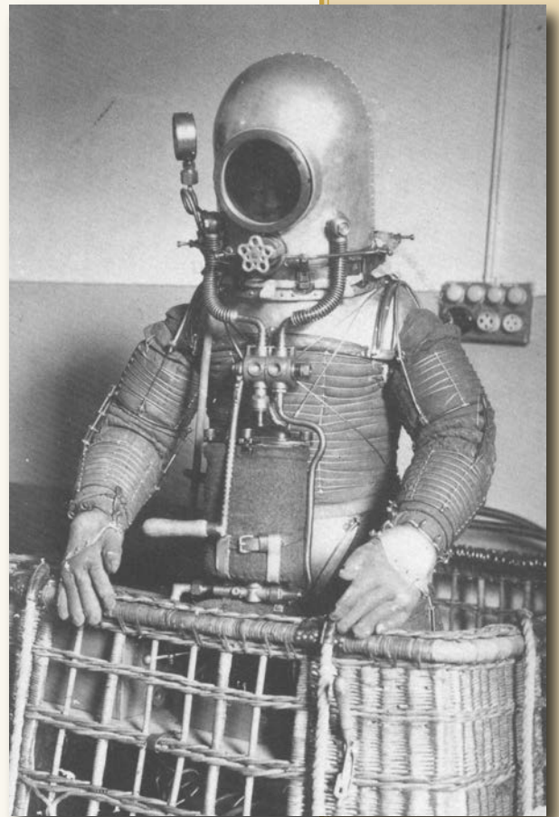
► Escafandra y traje espacial diseñados por Herrera para su proyecto de ascensión a la estratosfera.
