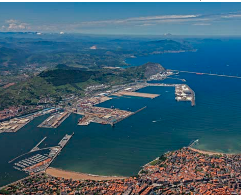
Abra exterior con toda la ampliación, año 2021.
