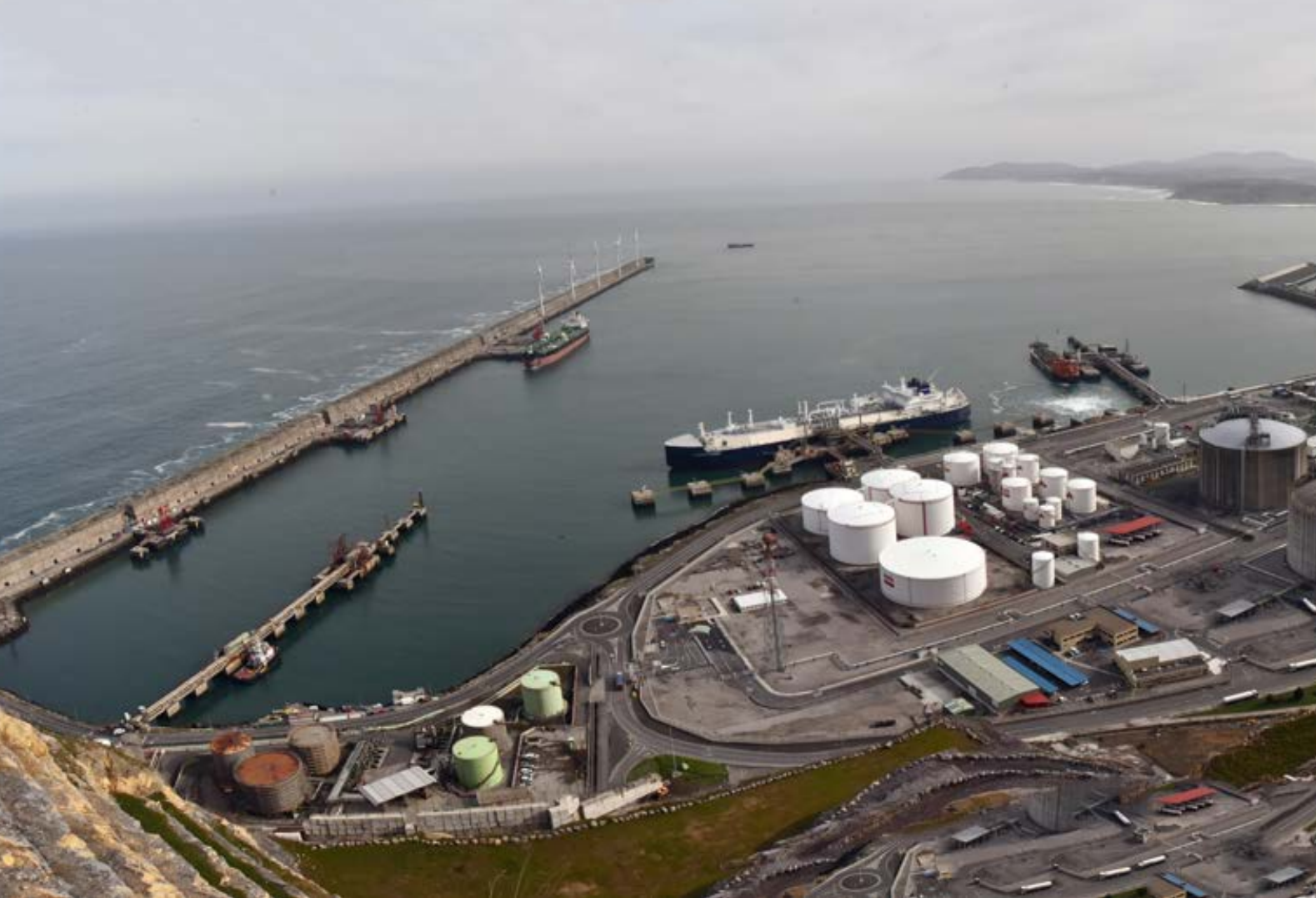
Zona industrial del Puerto en nueva superficie.
