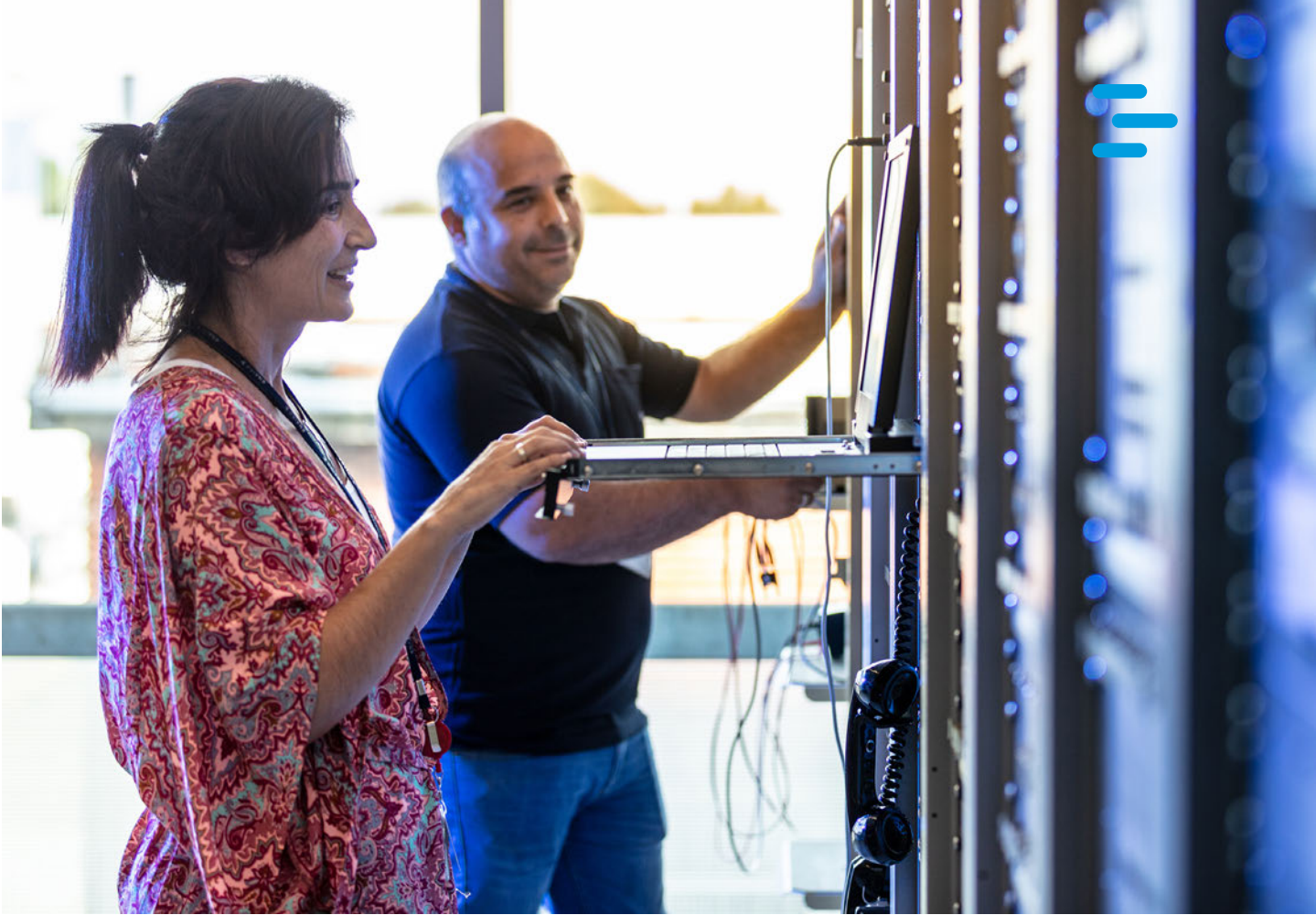
Personal de Mantenimiento en el Centro de Control de Área Terminal de ENAIRE en Santiago.
