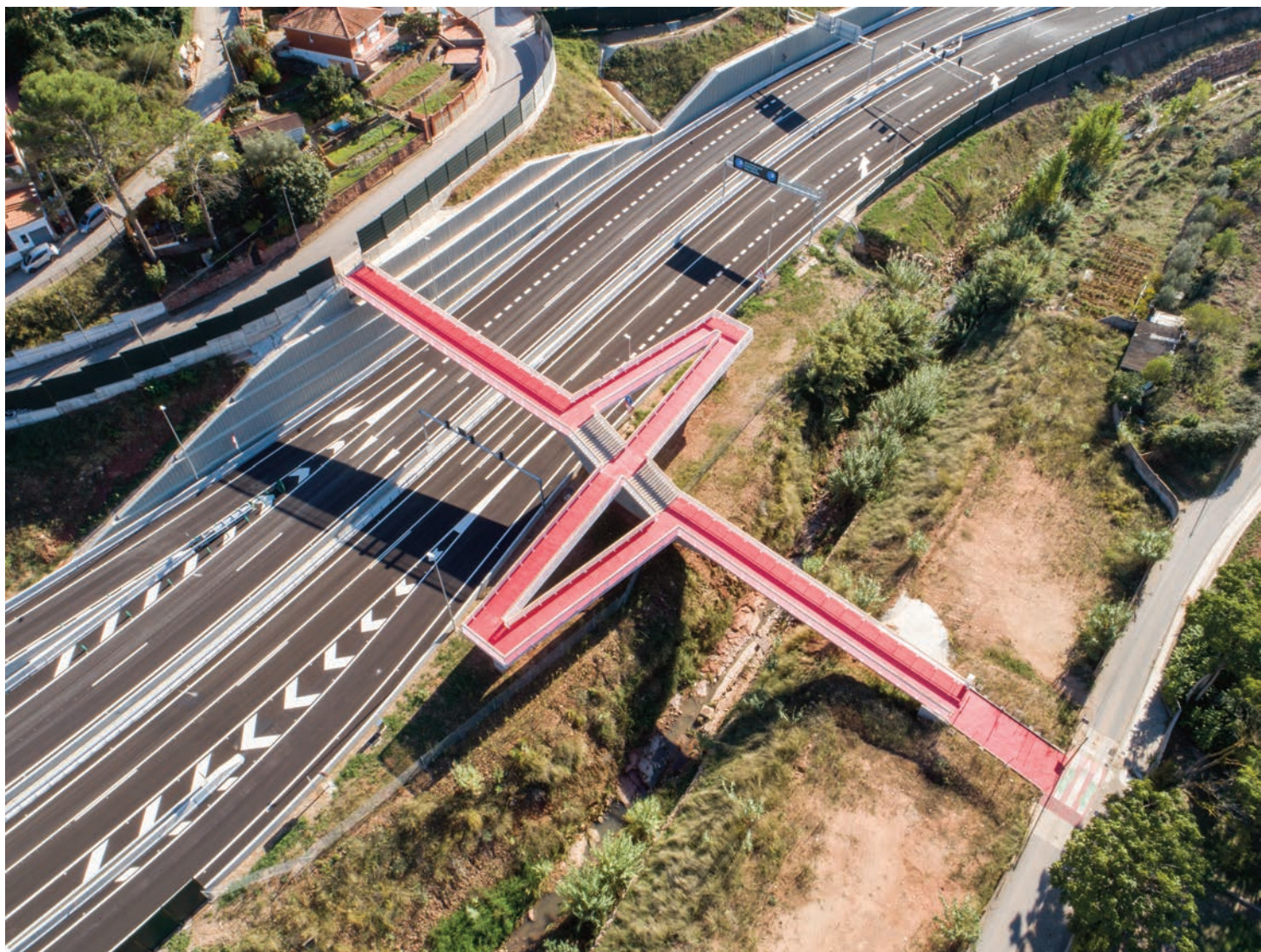
► Vista cenital de la pasarela sobre el tronco, que repone un camino interceptado por la autovía.
