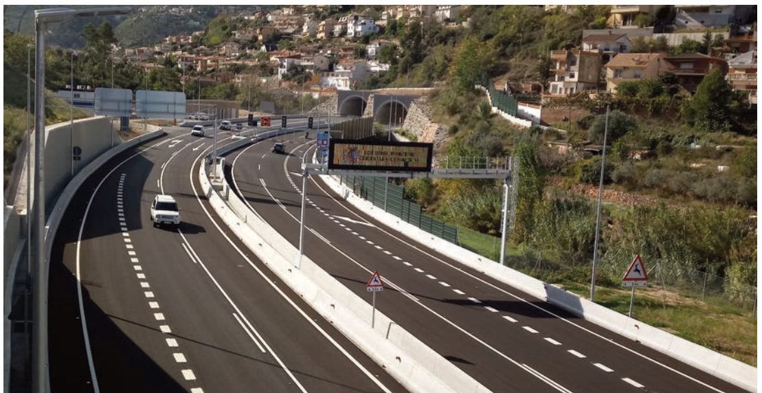
► Tráfico en la boca este del túnel, el día de la inauguración.
