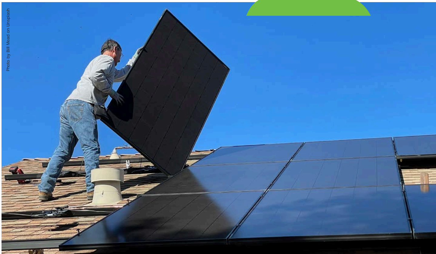
Colocación de placas solares en el tejado de una vivienda.
