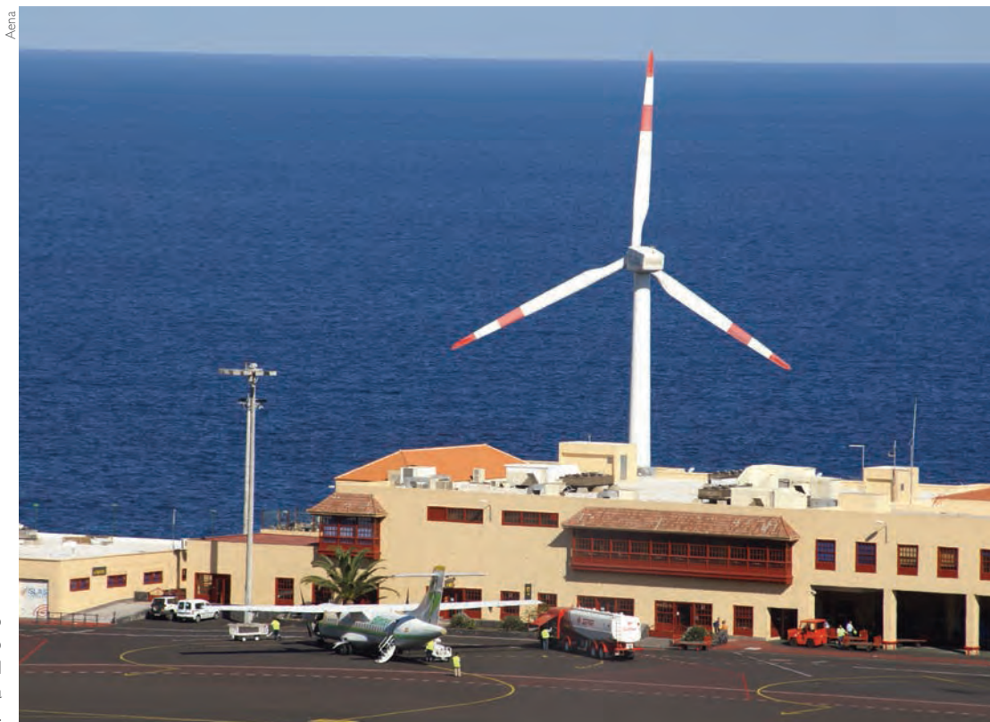
► Aerogenerador eólico para consumo propio instalado en el aeropuerto de La Palma (Tenerife, Canarias).
