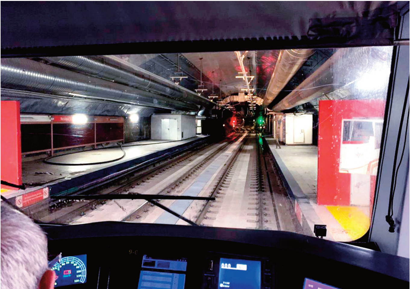
► Vista de la inacabada estación de Recoletos desde la cabina de un tren en pruebas.
