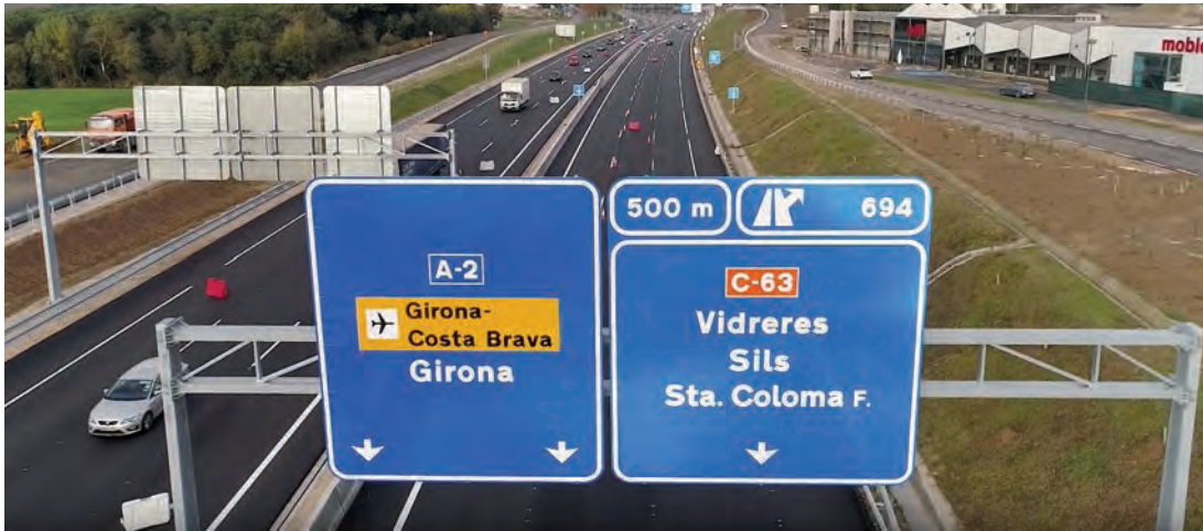
► El nuevo tramo mejora sustancialmente la capacidad de la carretera N-II.
