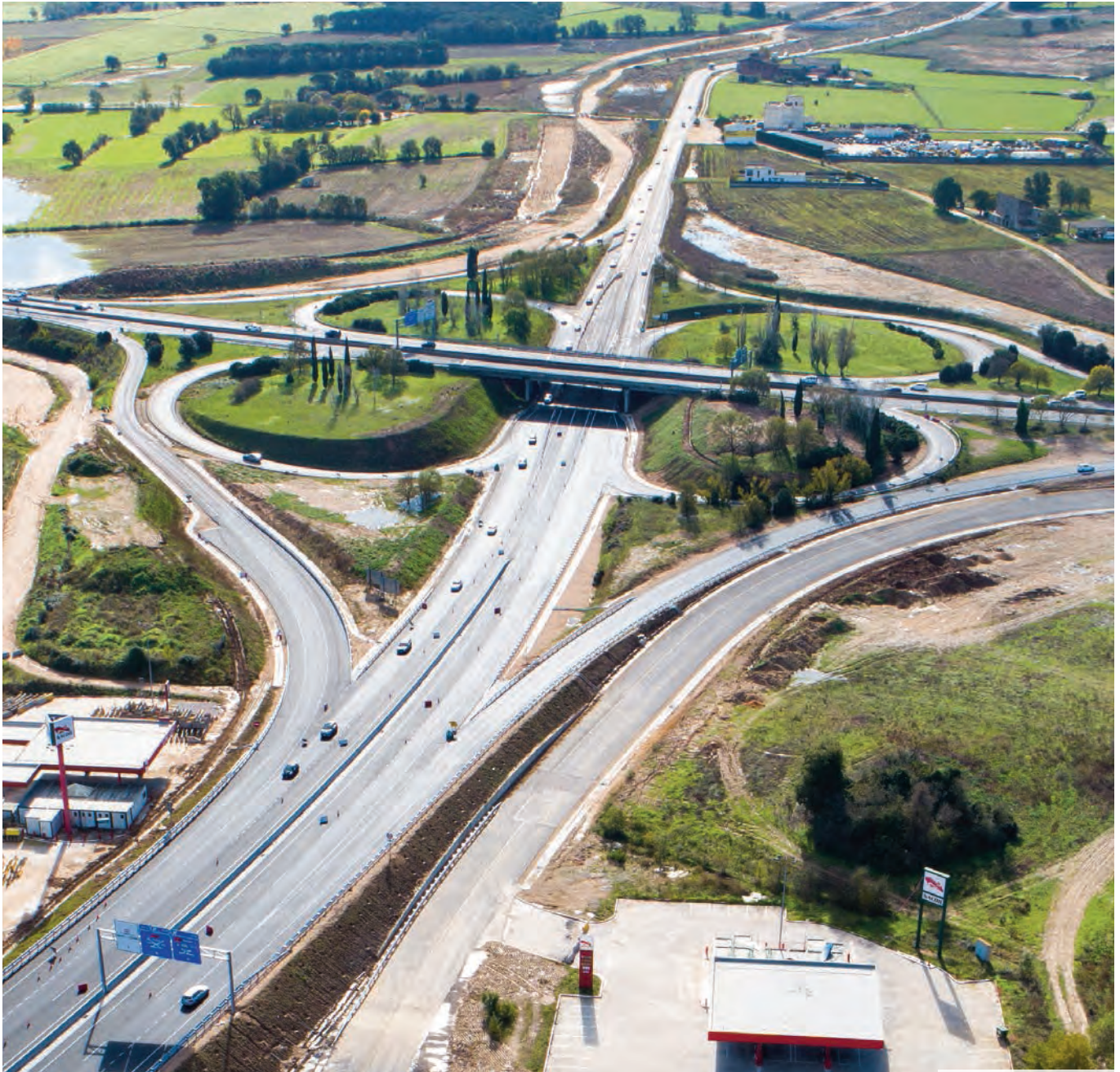
► Vista del enlace de Vidredes, final del tramo inaugurado.
