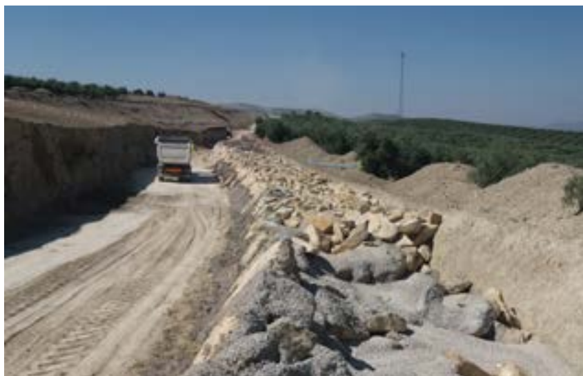
Tratamiento de terraplén.
