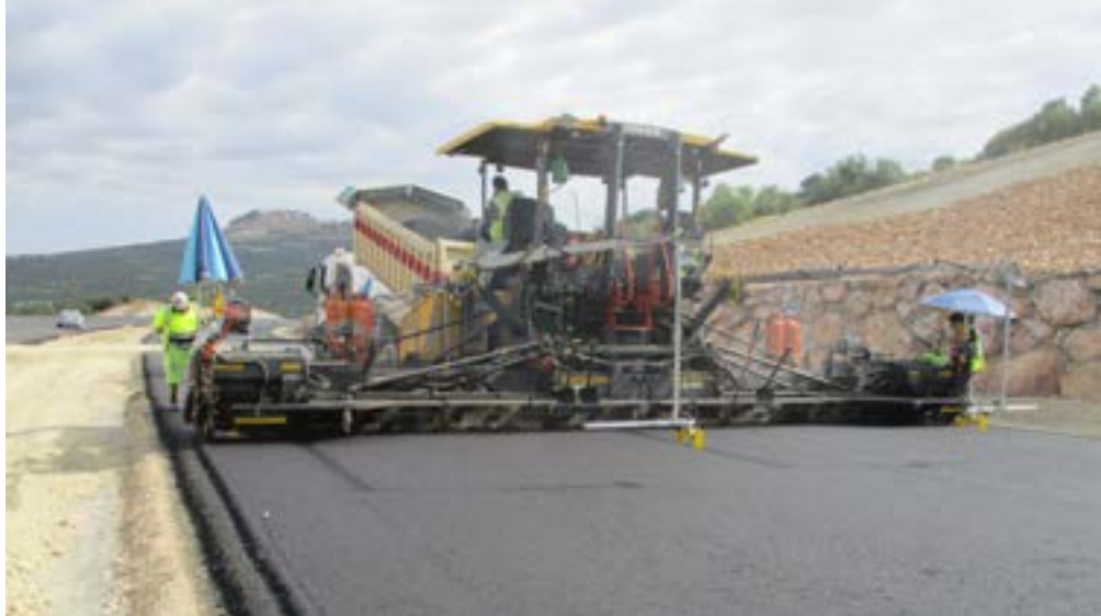
Extendido de la capa intermedia de firme mediante polvo de caucho procedente de neumáticos fuera de uso.
