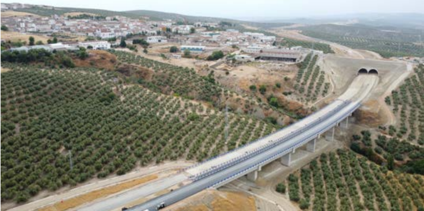
Viaducto de Arroyo de Arbullón y falso túnel, junto a Villacarrillo.
