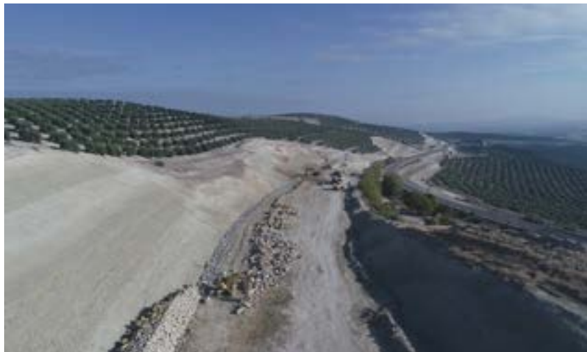
Tratamiento de escollera en desmonte.
