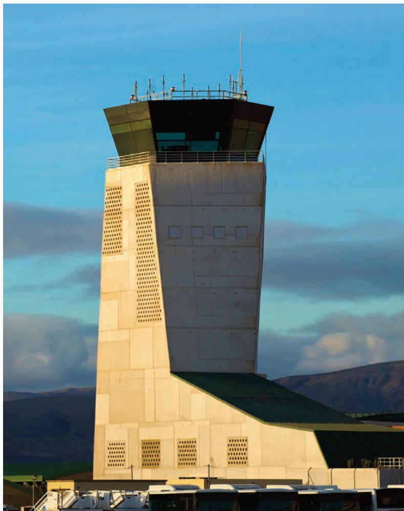
► Torre de control y, debajo, vía de servicios.
