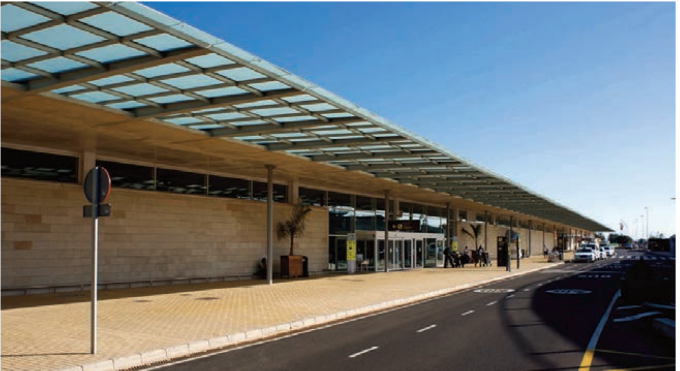
► Acceso principal y, debajo, dársenas y zona de parking.
