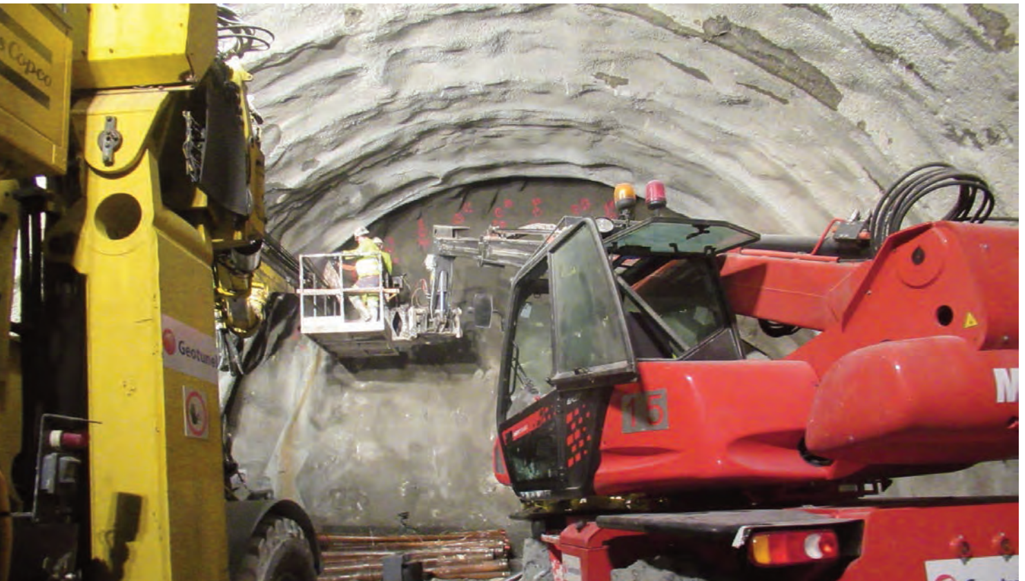
► Perforación de paraguas de micropilotes durante la fase de sostenimiento.
