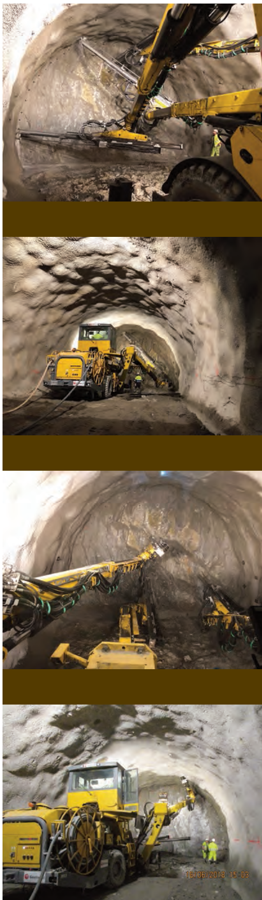
► Secuencia del proceso de sostenimiento.
