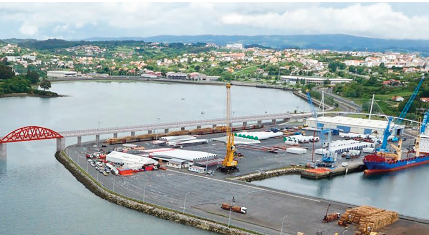
► Infografía del viaducto sobre la ensenada de A Malata y el muelle Fernández Ladreda, que tendrá 580 metros de longitud.
