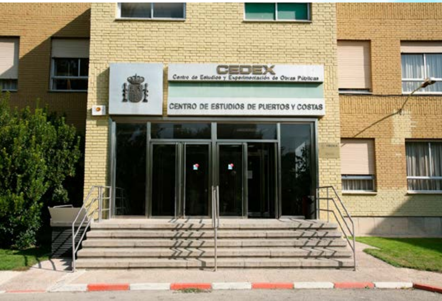
Acceso al Centro de Estudios de Puertos y Costas, centro que dirigió entre 1986 y 1989.
