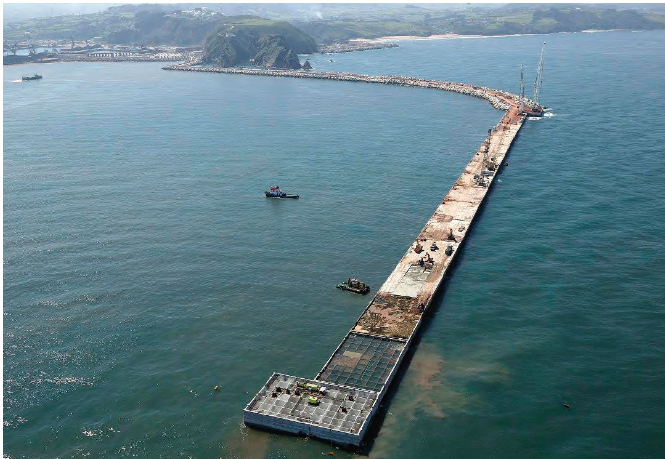
► Puerto de El Musel. Dique Norte de tipología vertical y fondeo de cajón
