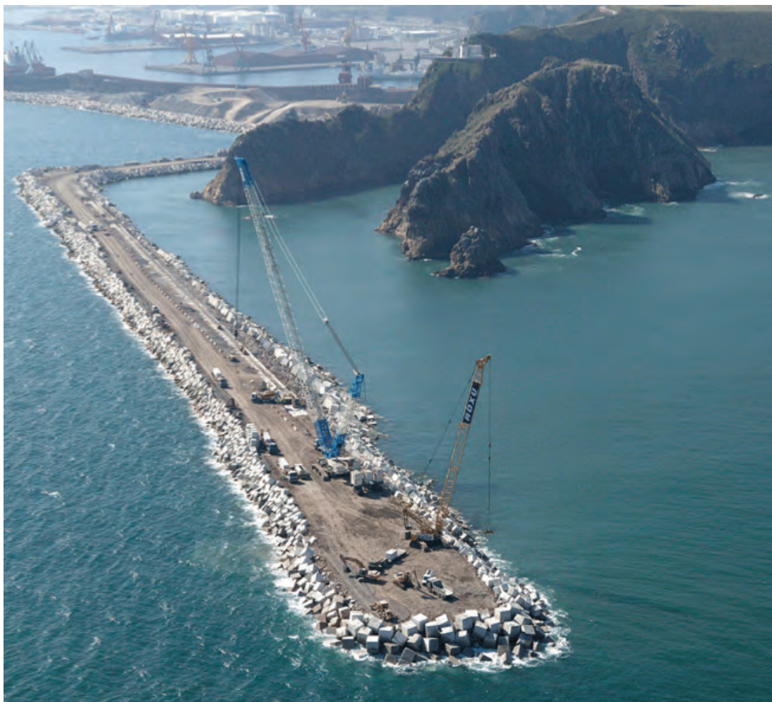
► Puerto de El Musel. Dique Tones en construcción preparado para los temporales de invierno.
