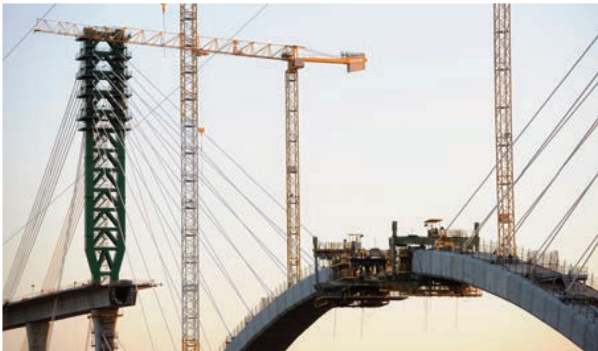
►Detalle de las torres metálicas de atirantamiento y hormigonado de las dos dovelas finales.
