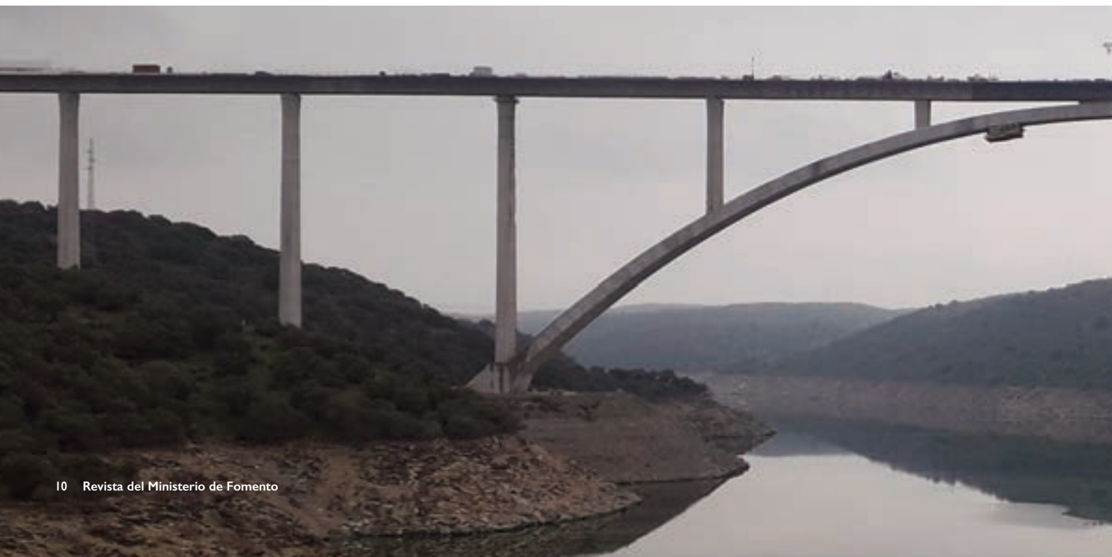
► Última fase de la construcción del tablero mediante cimbra apoyada directamente sobre éste.
