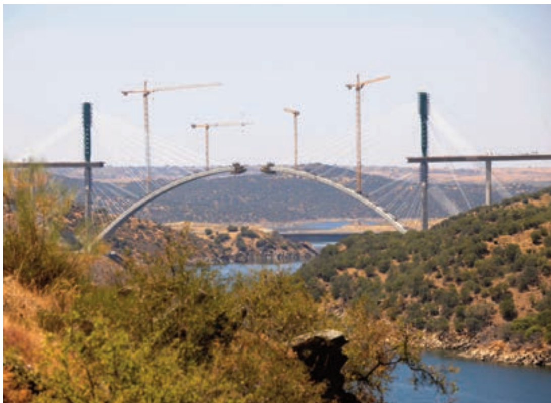
► Vista frontal antes del cierre del arco.
