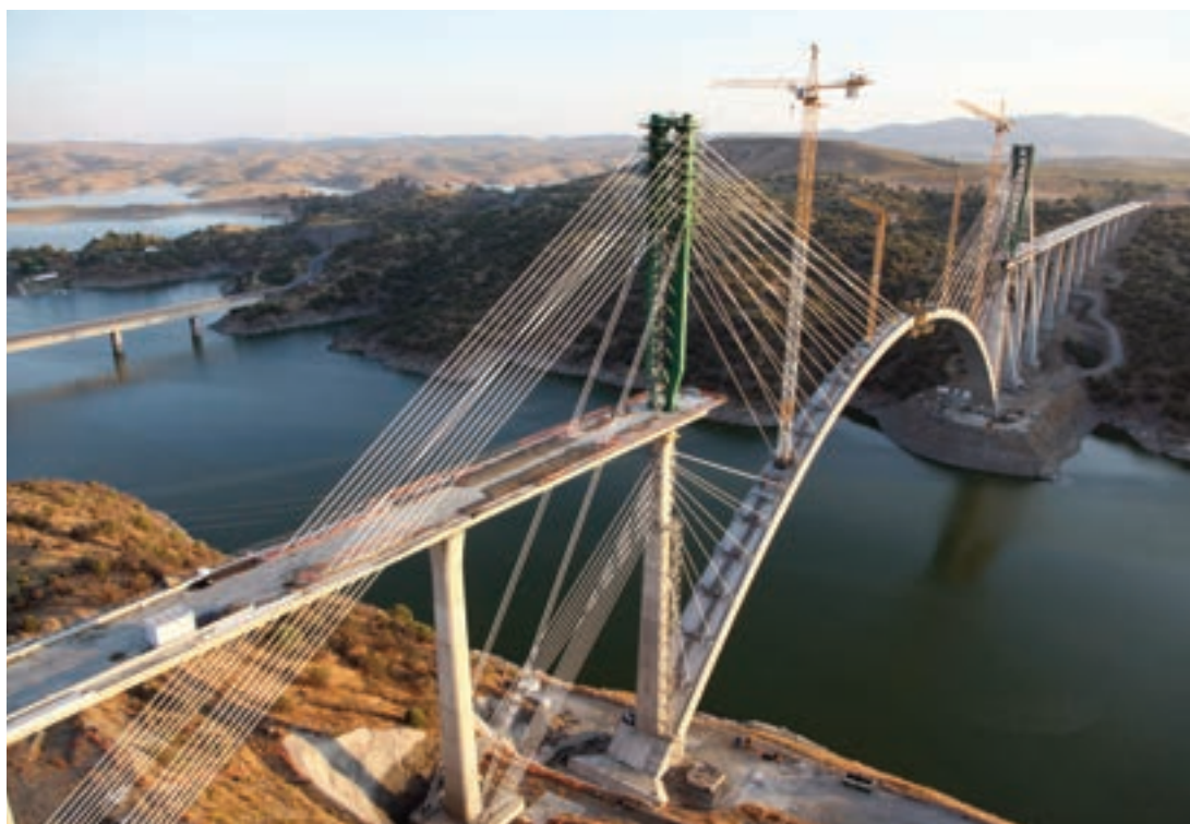
► Perspectiva desde el lado norte del viaducto.
