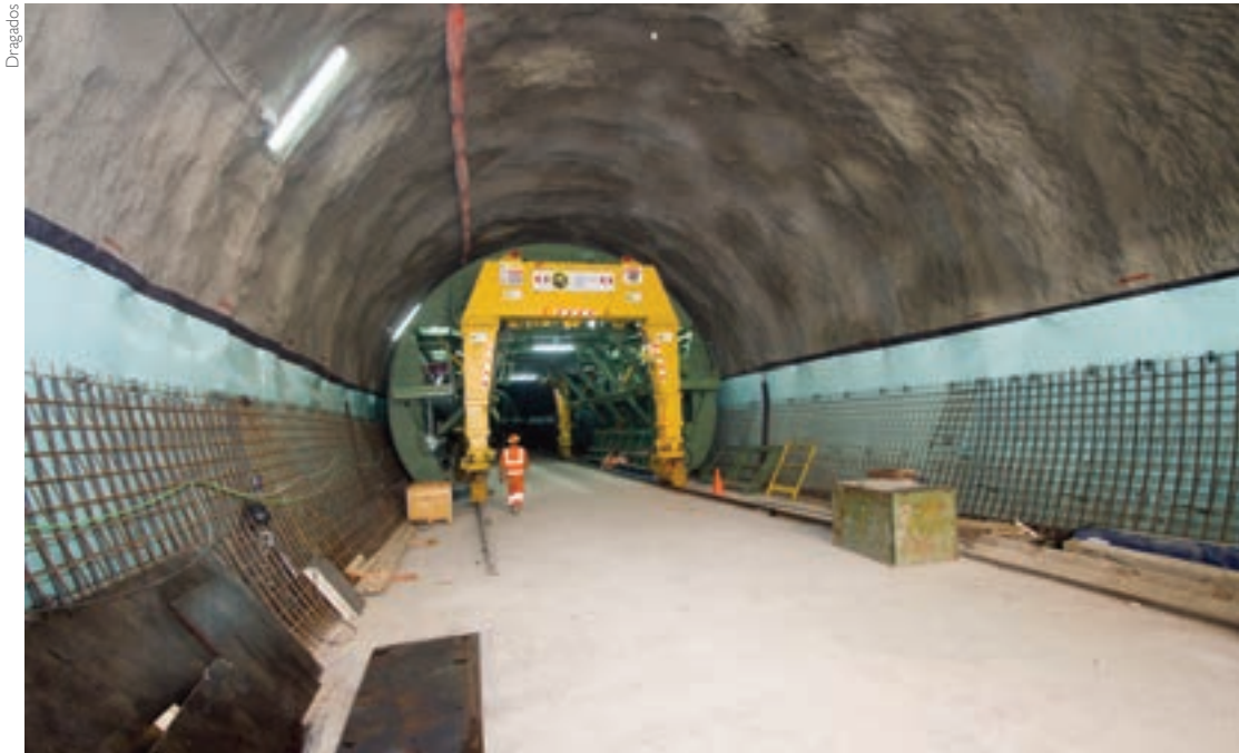
► Fase de revestimiento del túnel del metro de Lima.
