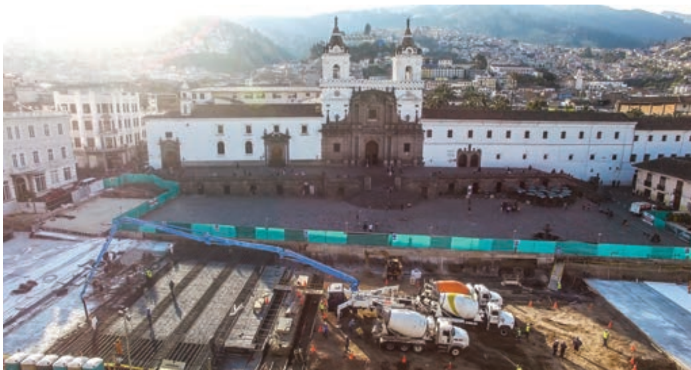
► Ejecución de la losa superior de compresión de la estación de San Francisco, junto a una de las joyas coloniales de Quito.
