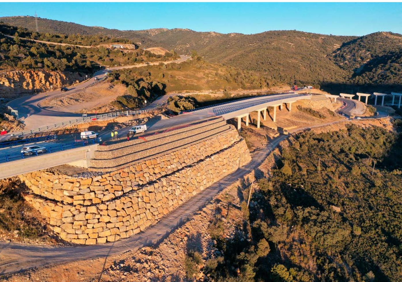
Muro de escollera ejecutado entre dos viaductos.
