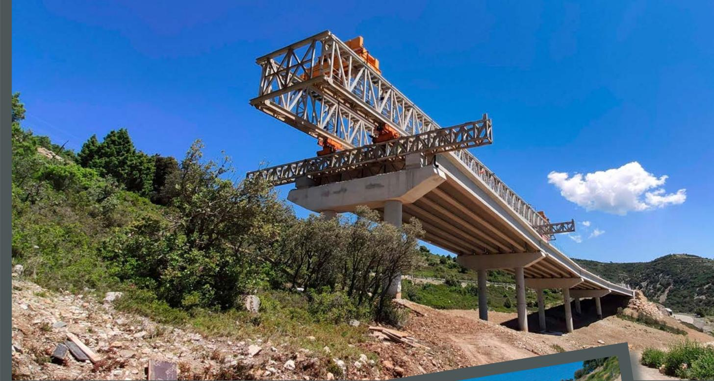
Equipo lanzador de vigas empleado en la ejecución de los viaductos.
