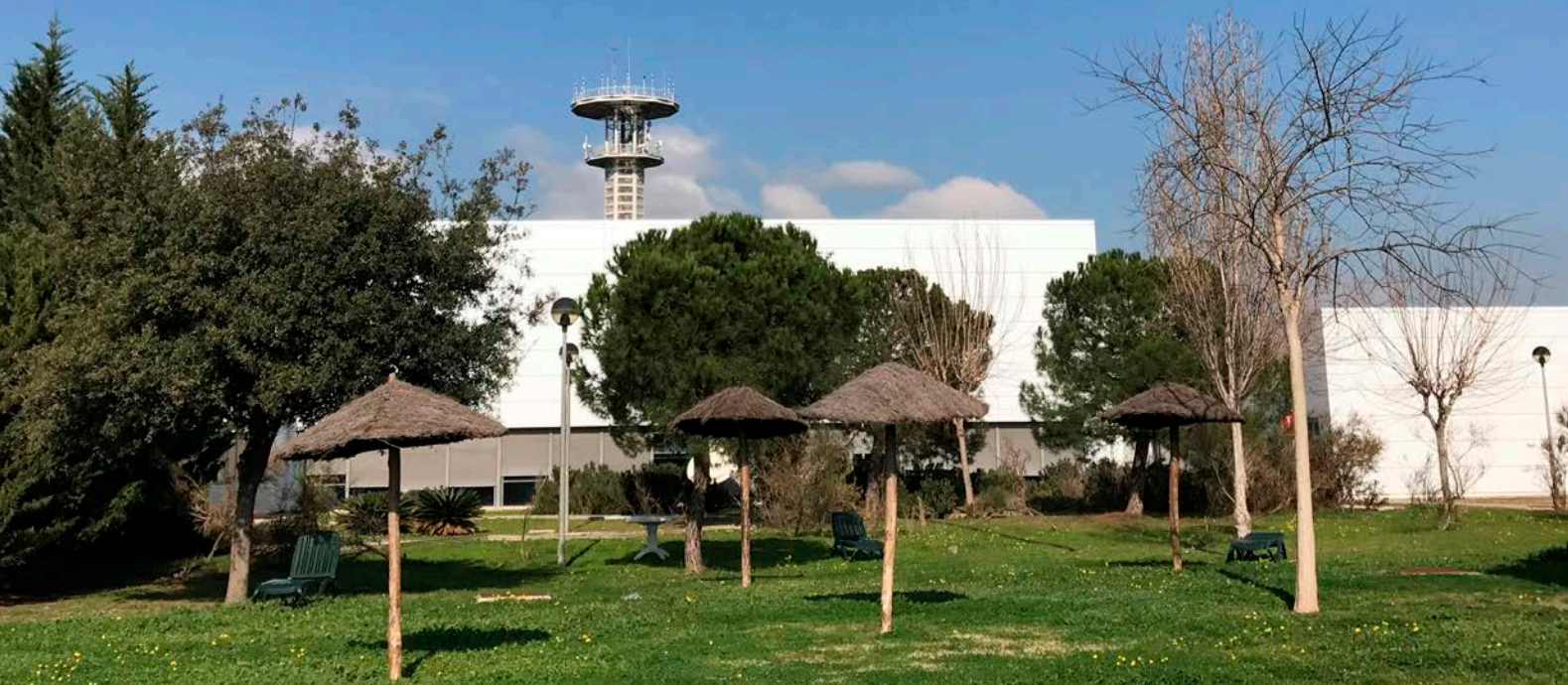
Exteriores del Centro de Control de ENAIRE en Barcelona.
