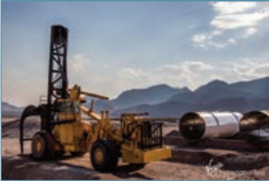
▶ Trabajos de ensamblaje del tubo Hyperloop One.
