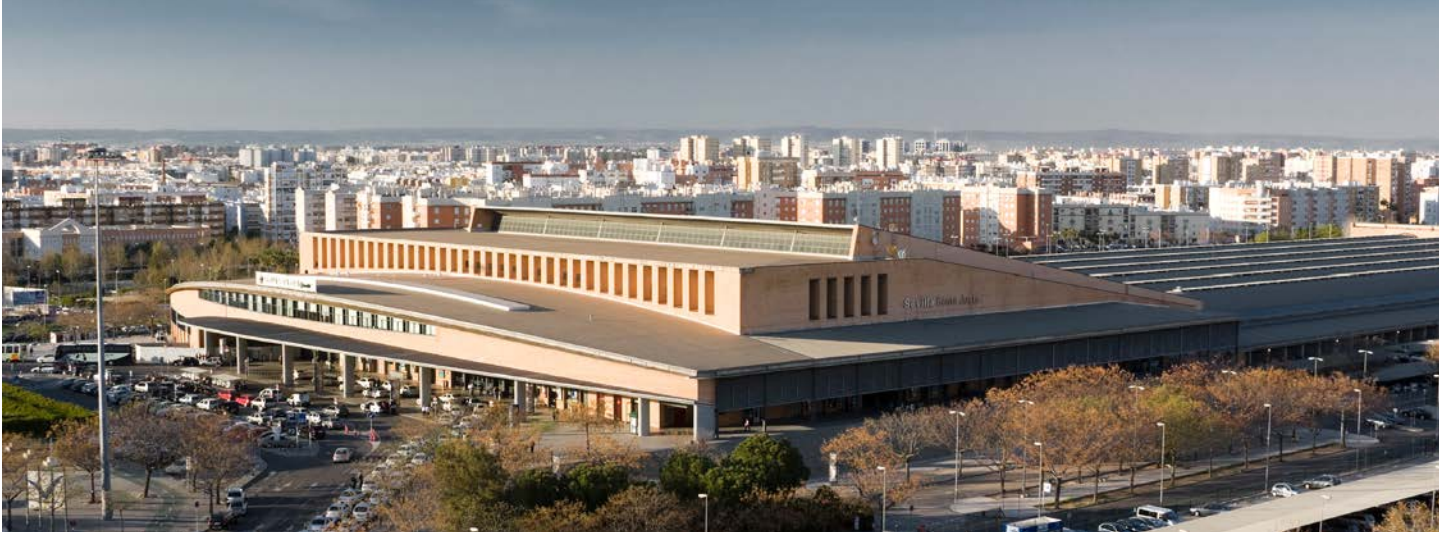
Uno de los principales proyectos del plan se ejecutará en la cubierta de la estación Sevilla Santa Justa.
