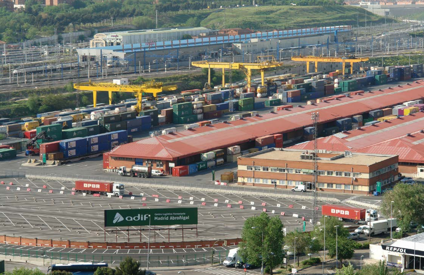
El centro logístico de Madrid Abroñigal incorporará paneles solares sobre varias instalaciones.
