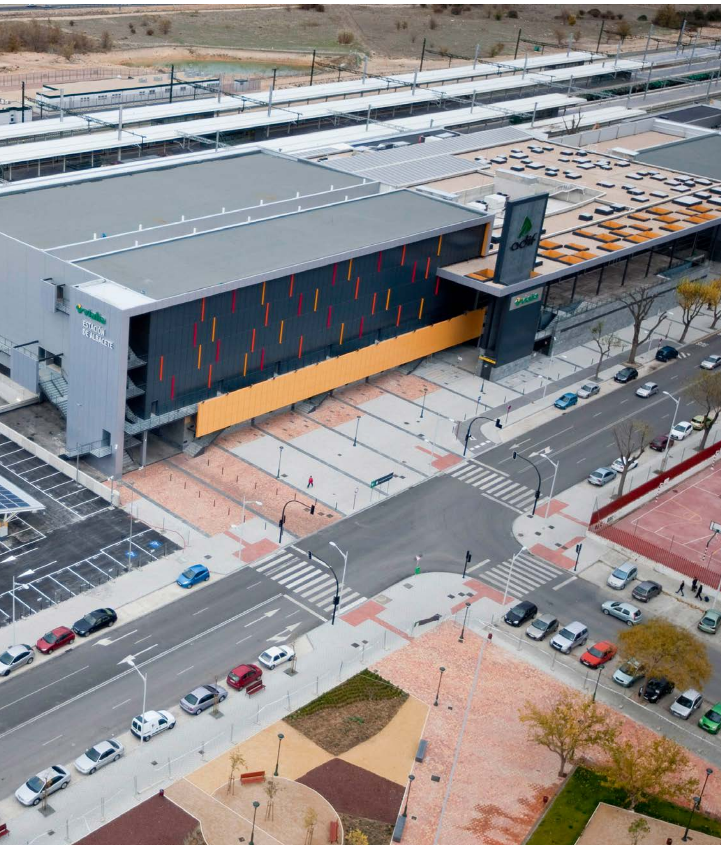
La cubierta de la estación vialia Albacete Los Llanos se poblará de paneles fotovoltaicos, ya presentes en las marquesinas del aparcamiento.
