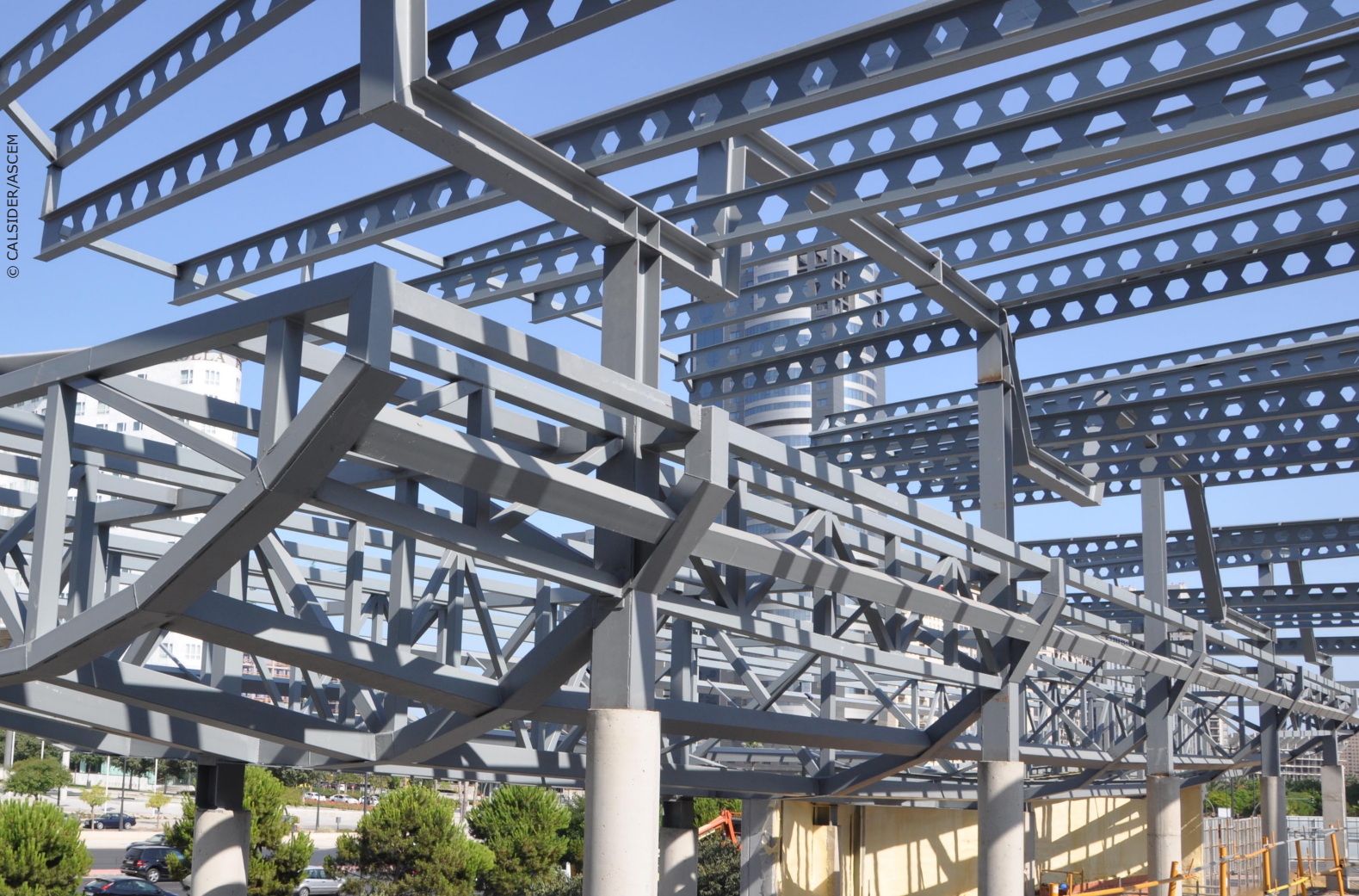
Estructura de acero (CALSIDER/ASCEM).
