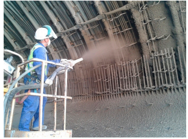
Puesta en obra de hormigón proyectado.
