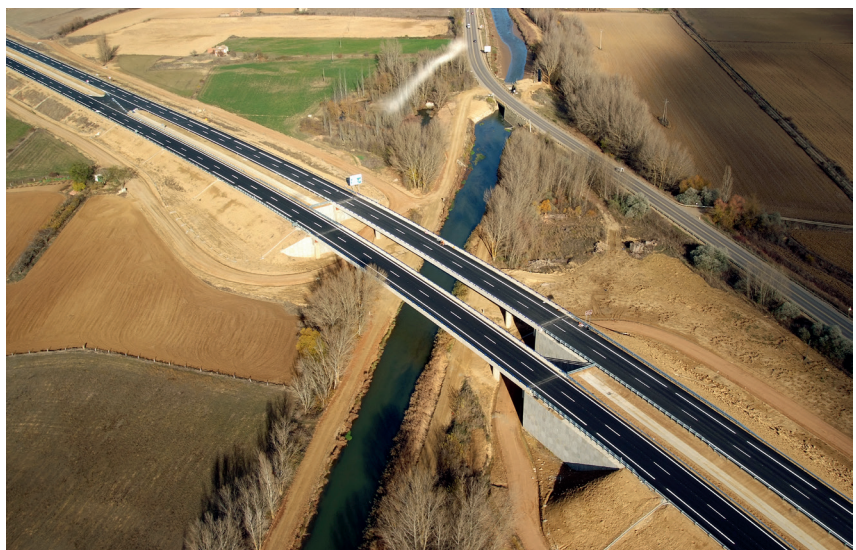
Viaducto sobre Canal de Castilla.
