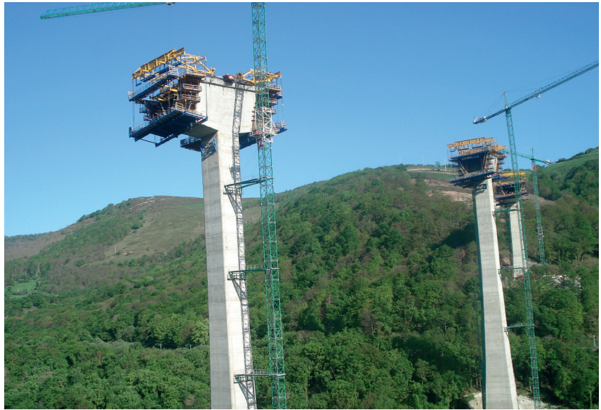
Obras de Montabliz.
