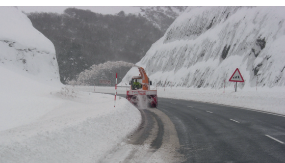
Centros de conservación y de control de túneles; boca del túnel Nogales, y vialidad invernal.
