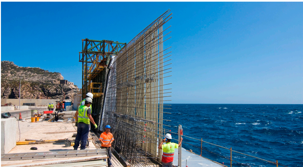
Colocación de la armadura.
