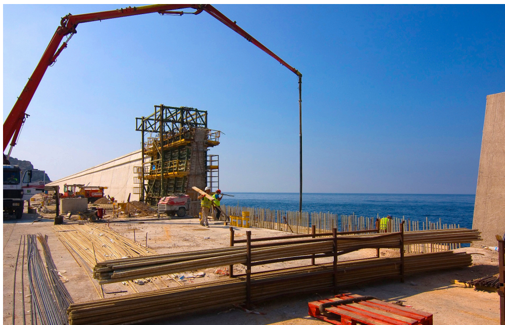
Hormigonado de la zona de apoyo.
