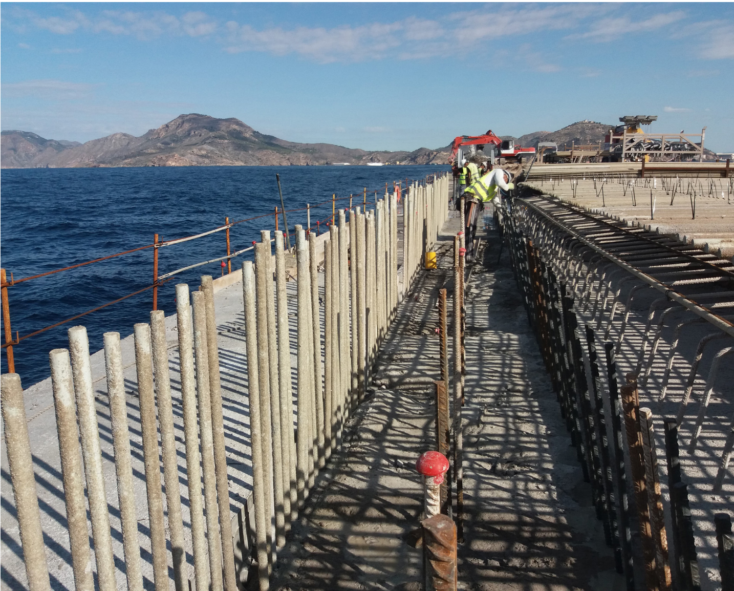
Esperas de conexión de PRFV y Acero.
