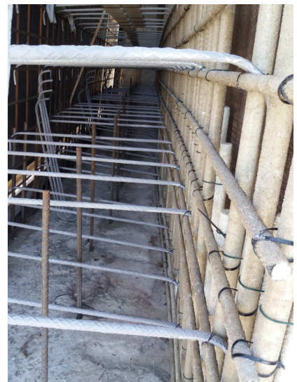
Armado interno del espaldón (finalizado).
