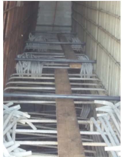
Armado interno del espaldón (en ejecución).
