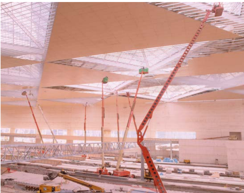
Ejecución de la singular cubierta de la estación.
