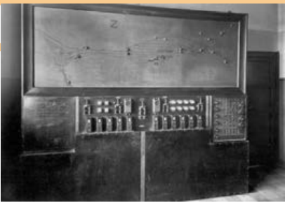
Cuadro de repetición y maniobra de las señales de Zaragoza Delicias en el despacho del jefe de Estación.
