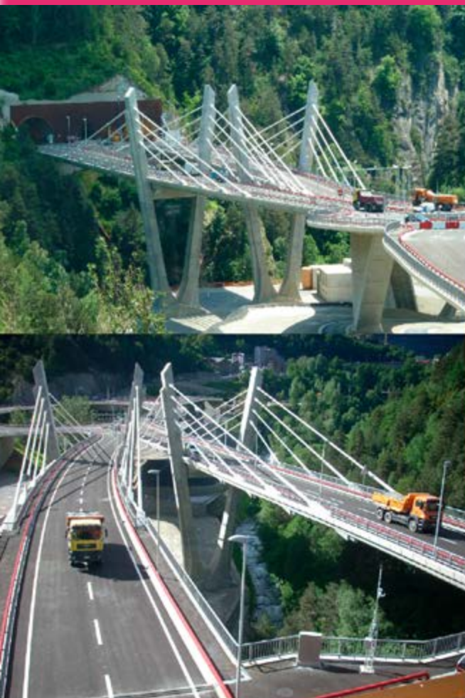
Inspección del viaducto de Orión (2008), construido con el método de avance en voladizo.
