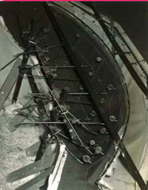
Ensayo del modelo de la presa de Santa Ana (1953).
