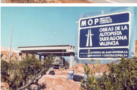
De arriba abajo, área de servicio La Plana, construcción autopista, inauguración en 1976 tramo San Juan-Altea, autoridades en la inauguración de Silla Xeresa en 1976, y señalizaciones en la década de los 70.
