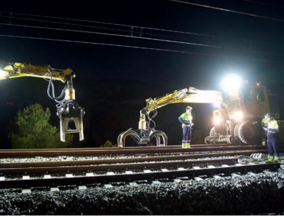
Trabajos de tendido de vía y catenaria en el tramo.
