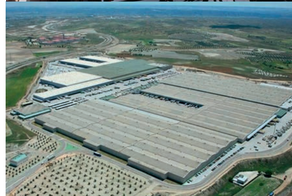
Depósito elevado del Canal de Isabel II y vista aérea del almacén de Valdemoro proyectado por M. Aguiló.
